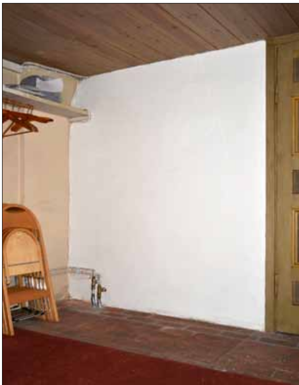
15 I tornets bottenvåning togs ett säkerhetsskåp bort i samband med konverteringen av värmesystemet (SIm D12-0367).
