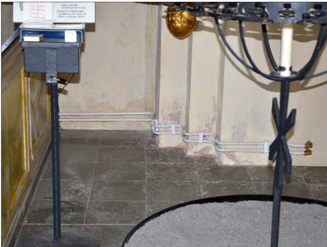
13 Rördragning för det vattenburna värmesystemet på långhusets norra ytermur mellan bänk- kvarteret och predikstolen (Slm D12-0365).
