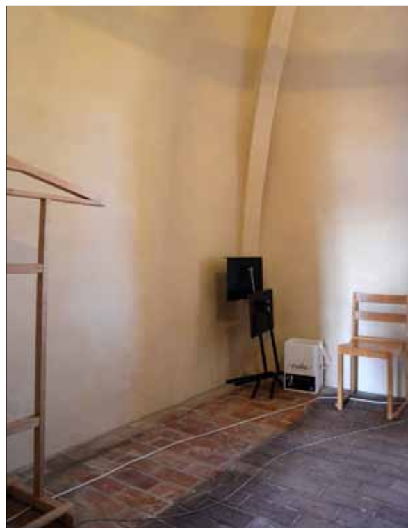
10 Det nordvästra hörnet efter avslutade rengörings- och putsarbeten (Slm D12-0362).
