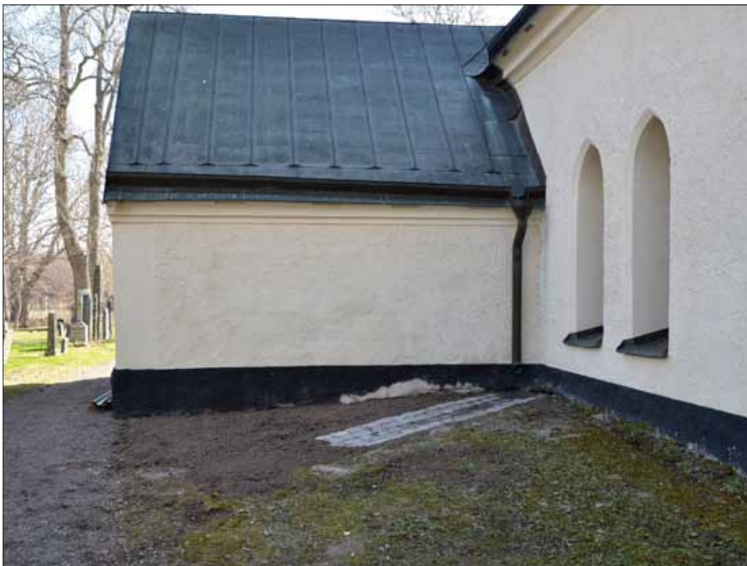
4 Hörnet mellan sakristians västra och långhusets norra fasader efter avslutade arbeten. Fotografiet är taget vid slutbesiktningen i april 2011 (Slm D12-0356).
