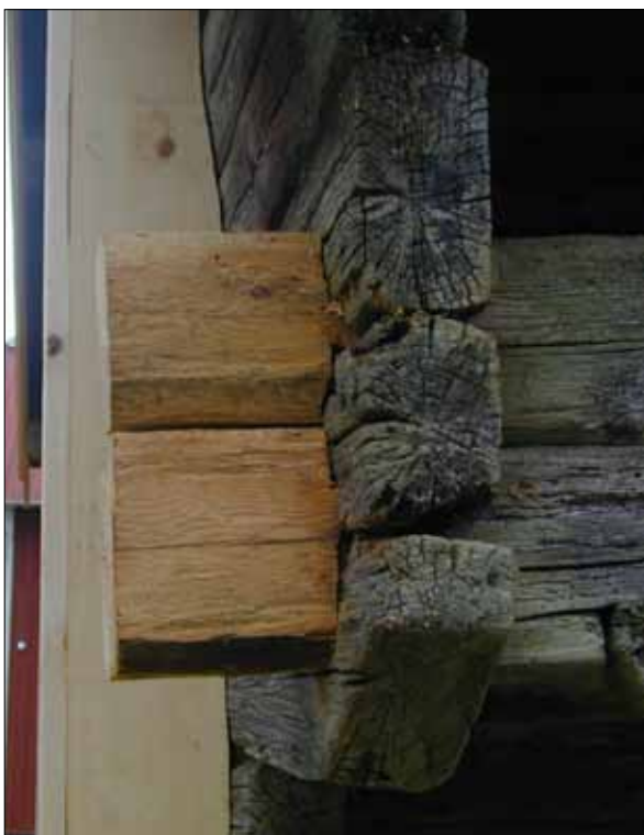
12 Detalj av östra loftbodens lagade knut. Knutkedjan bakom har klätts in (Slm D12-0287).
