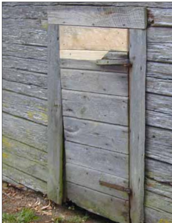
11 Dörren i östra loftbodens västra gavel. Övre delen lagades i med nytt virke (Slm D12-0286).
