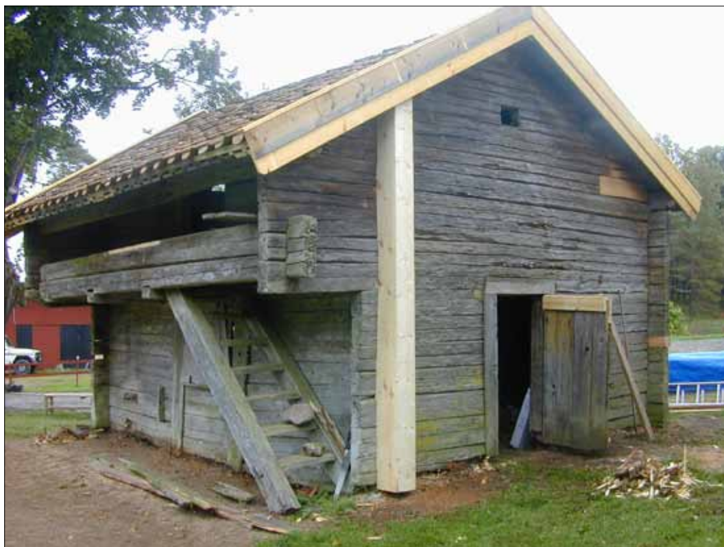
7 Östra löftboden sedd från norr i september 2003 (Slm D12-0279).
