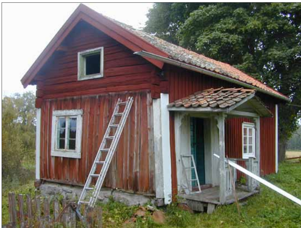
16 Enkelstugan sedd från sydväst. Västra gaveln har tidigare varit utkragad och vilat på träpelare. Det synliga timrade gavelröset är alltså ursprungligt och panelen är uppsatt senare. Observera de ursprungliga syllstockarna som också syns, september 2003 (Slm D12-0291).
