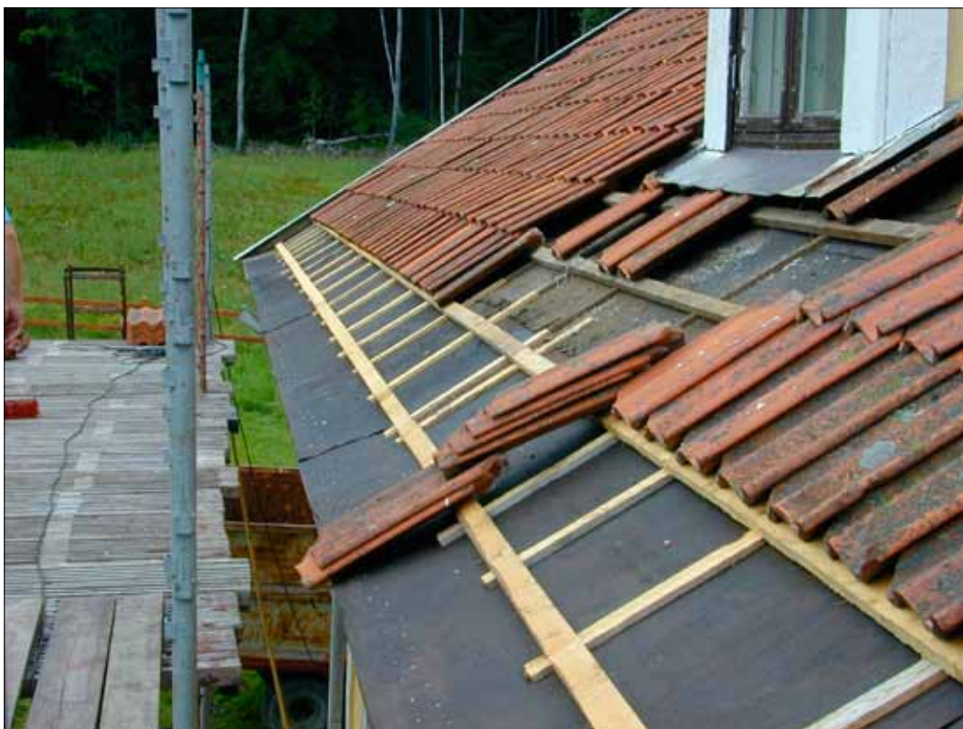
5 Den nedre våden på södra sidan täcktes helt med ny dubbel papp, som impregnerades på plats, augusti 2004 (Slm D12-0269).
