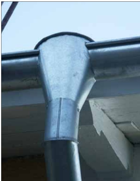
10 Nya hängrännor och vattkuper sattes upp. Vattkupan är justerad efter synpunkter, slutbesiktningen i december 2004 (Slm D12-0274).
