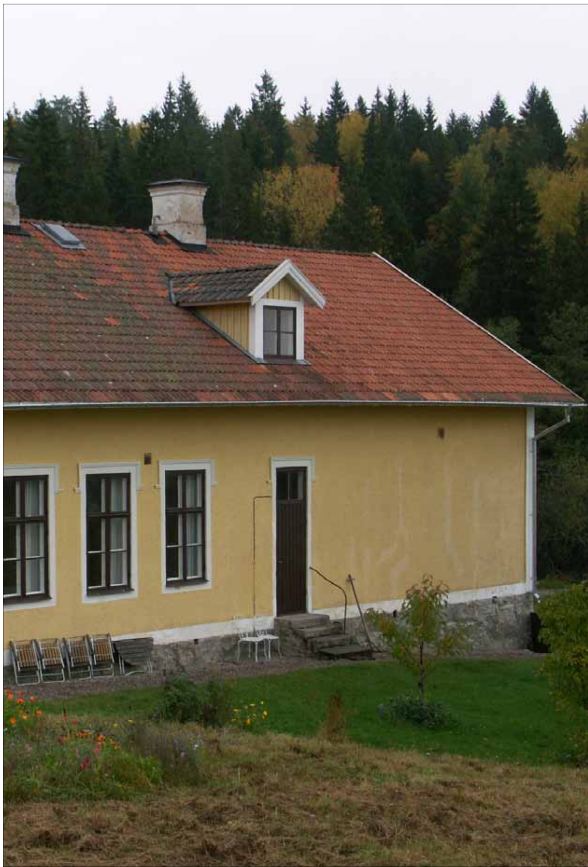
14 Del av Solviks skola sedd från söder efter avslutade takreparationer (Slm D12-0278).
