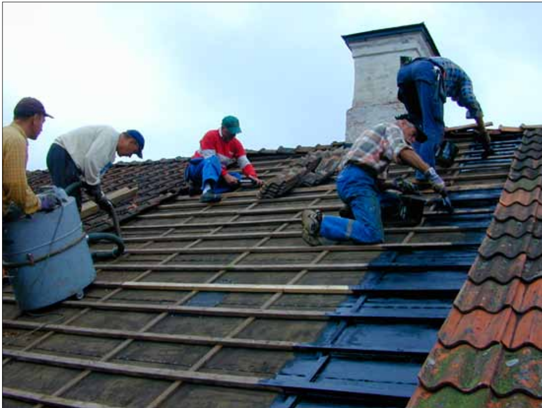
8 Den befintliga äldre takpappen dammsögs och ströks med stenkolsolja, september 2004. Arbetena utfördes av Per-Inge Björn, Eddy Pauli, Gunnar Widæus, Hans-Ivar Andersson och Gerhard Skogsund, Stiftelsen Solviks skola (Slm D12-0272).
