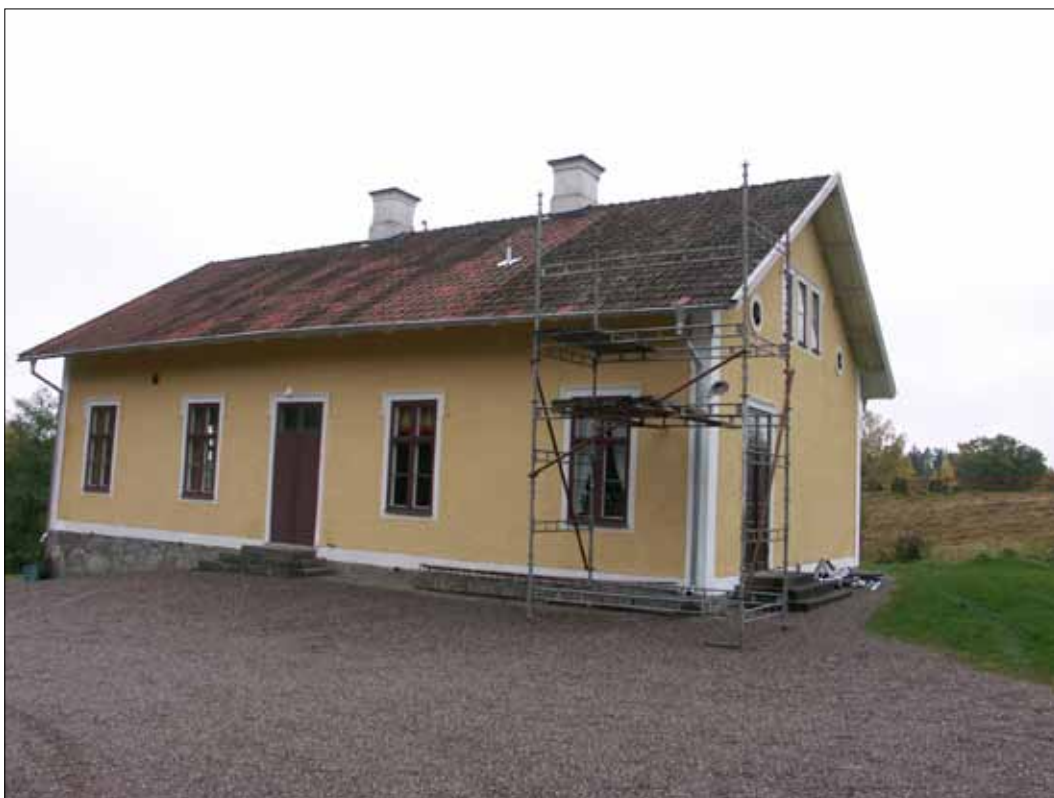
13 Solviks skola sedd från norr efter avslutade arbeten (Slm D12-0277).
