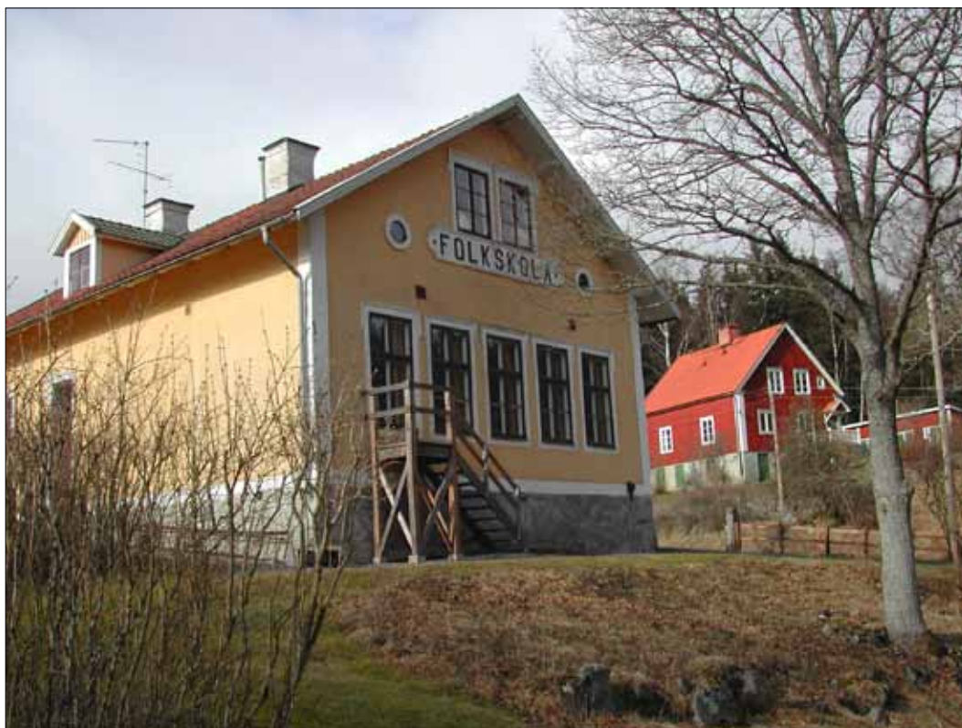
2 Solviks skola sedd från sydost i april 2002 (Slm D12-0267). I bakgrunden syns den före detta lärarbostaden och längan.
