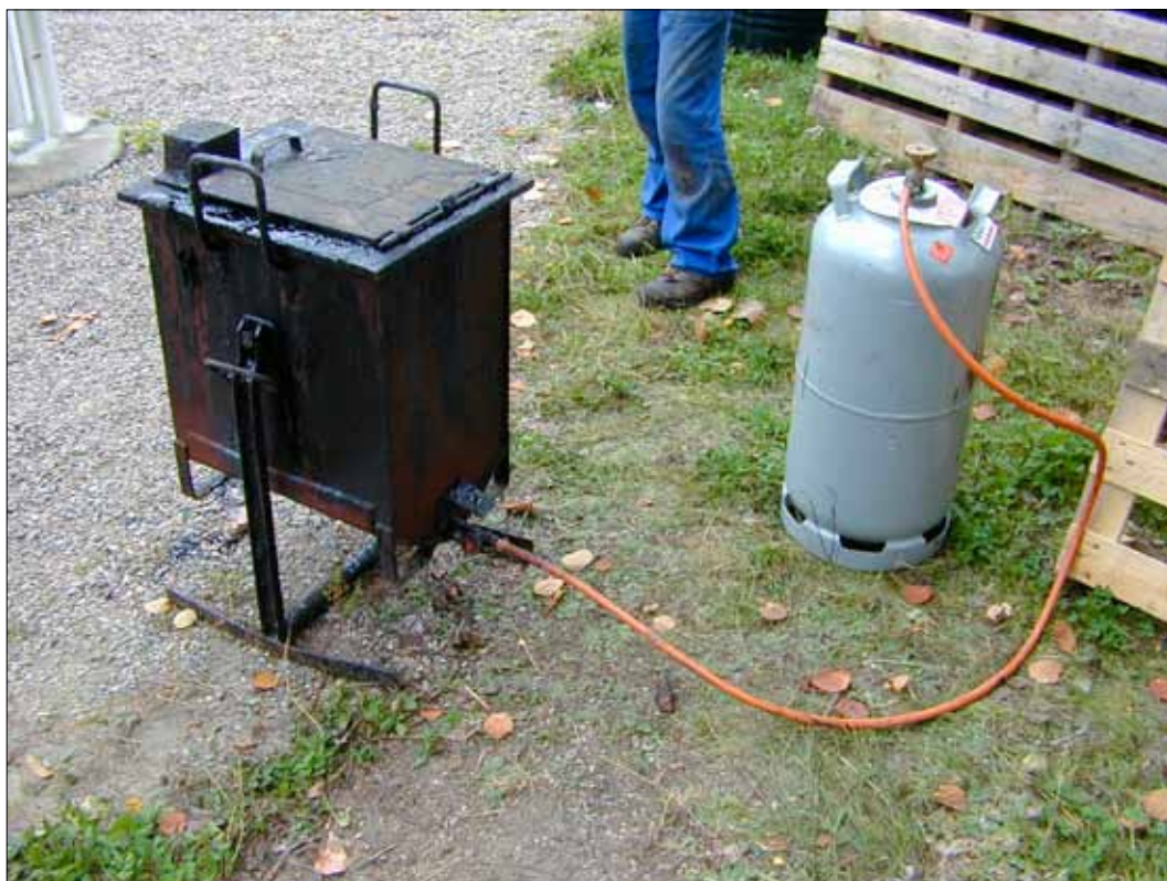
7 Stenkolstjära upphettades på plats, för att tjäran skulle vara lätt att stryka ut (Slm D12-0271).
