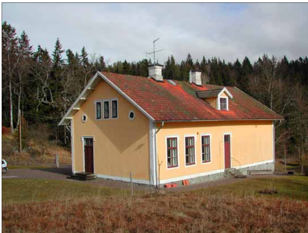
4 Skolhuset sett från sydväst i april 2002 (Slm D12-0268).
