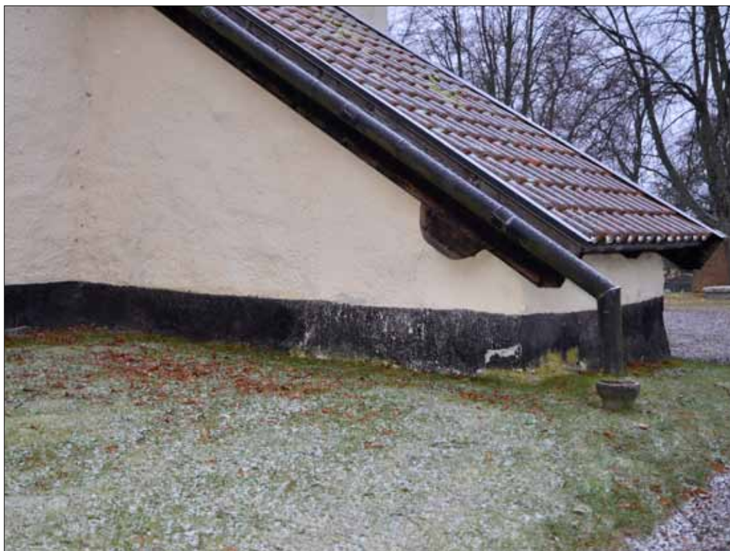
10 Strävpelarens nordöstra hörn före påbörjad schaktning (Slm D12-0380).
