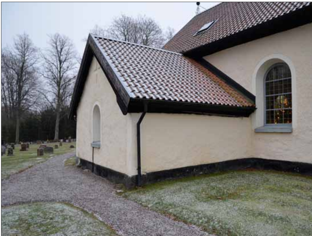
8 Sakristians nordvästra hörn före påbörjad schaktning (Slm D12-0378).
