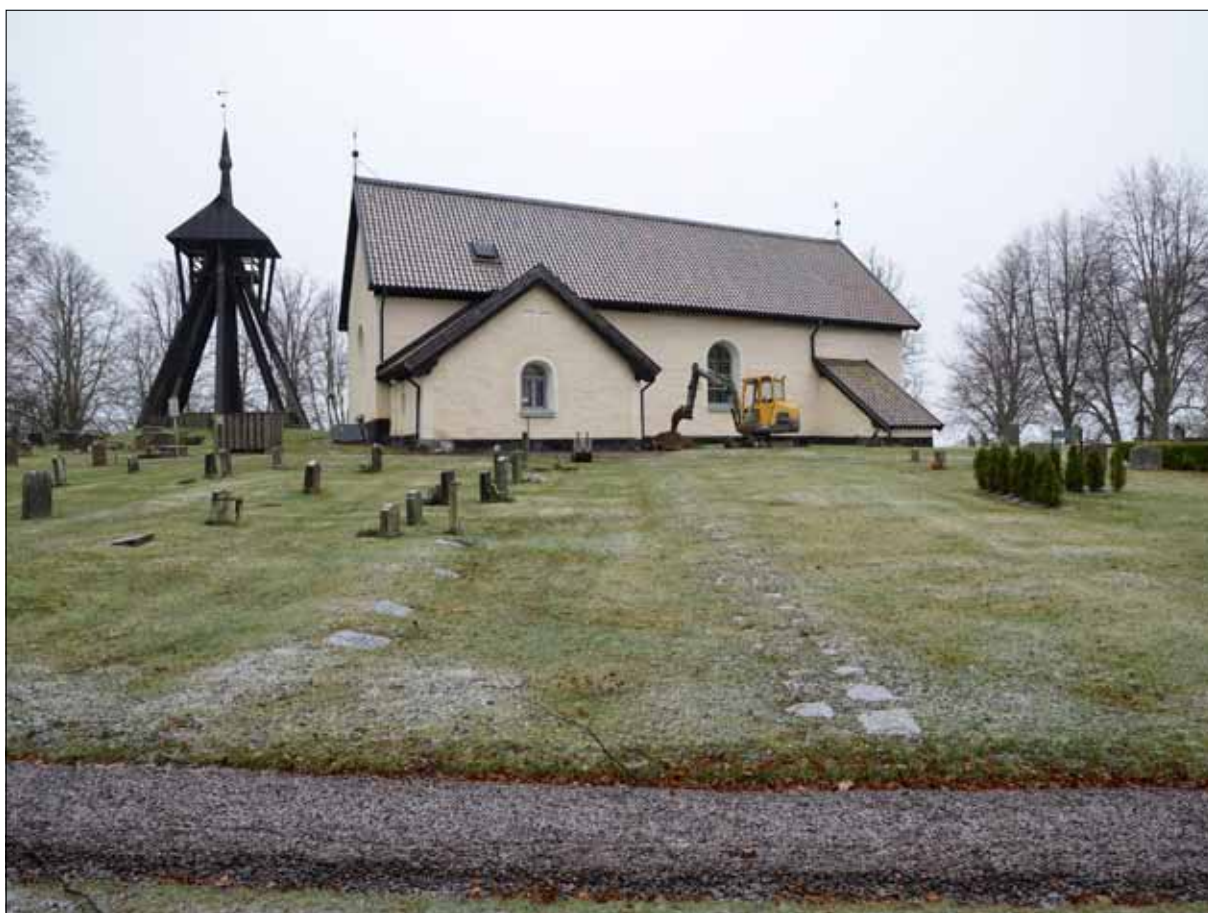
2 Råby-Rönö kyrka från nordost i samband med schaktning invid sakristians nordvästra hörn (Slm D12-0373).
