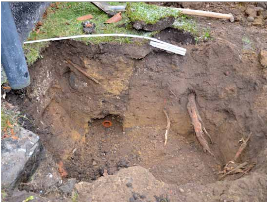
9 Schakt 3 från norr. På bilden framträder nedgräningskanten för dräneringsledningen tydligt (Slm D12-0379).
