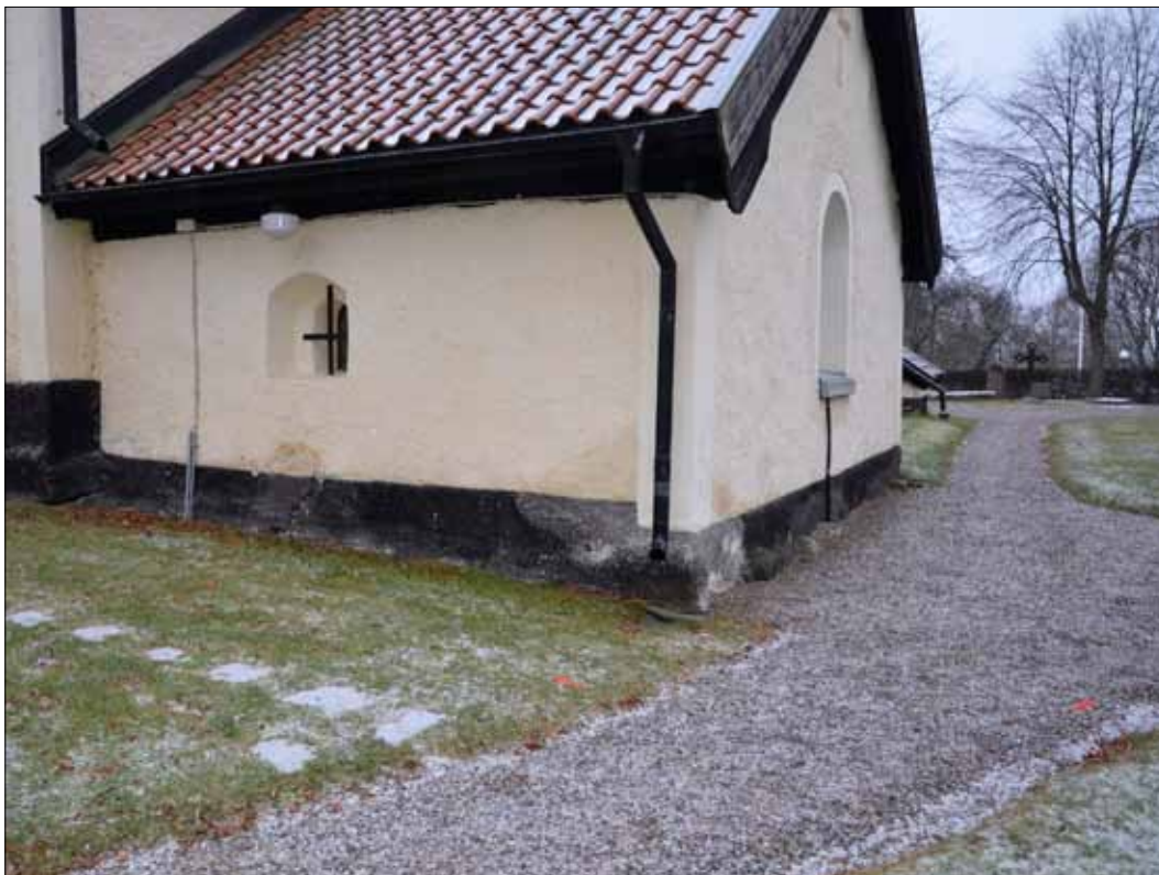
6 Sakristians nordöstra hörn före påbörjad schaktning (Slm D12-0376).
