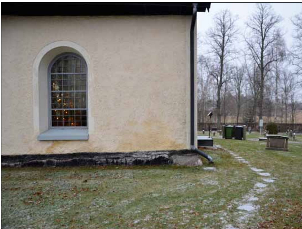
4 Korets södra fasad före påbörjad schaktning (Slm D12-0374).
