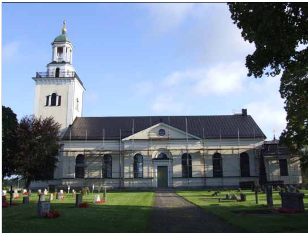
2 Öja kyrka sedd från söder vid slutbesiktningen den 4 september 2008 (Slm D12-0242).
