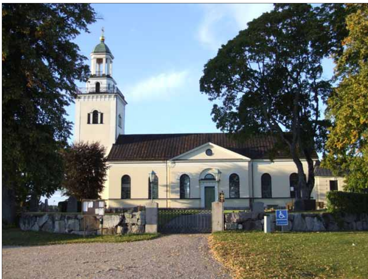
3 Öja kyrka sedd från söder i september 2007 före takrenoveringen (Slm D08-789).
