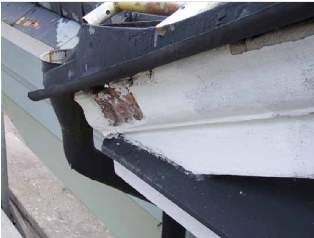
9 Detalj av östra takfotsdelen på norra fasadens mittrisalit där putsen hade släppt (Slm D12-0247).
