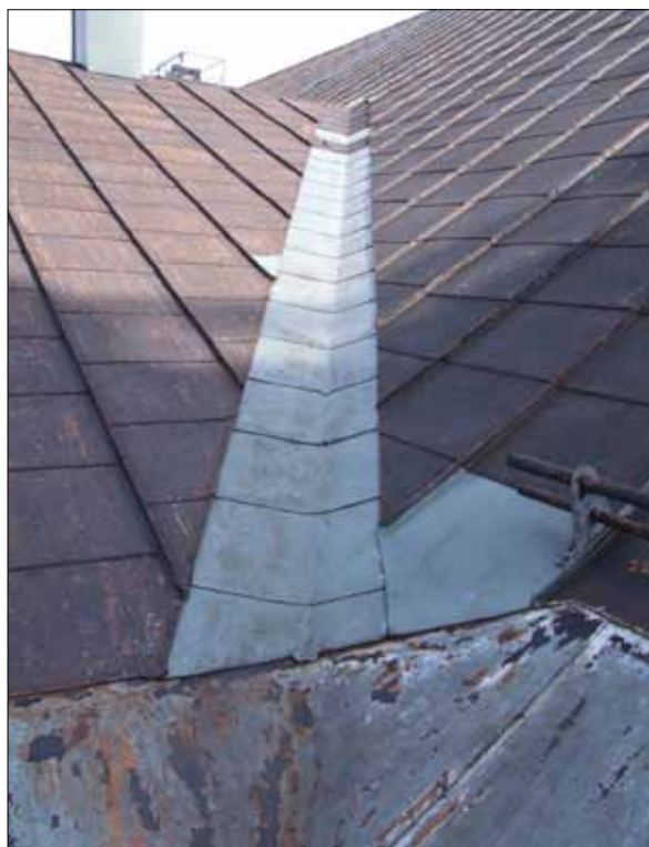
20 Norra takfallets vinkelränna, västra sidan, efter plåtbyten. Fotografi Kjell Taawo, Sörmlands museum (Slm D12-0258).
