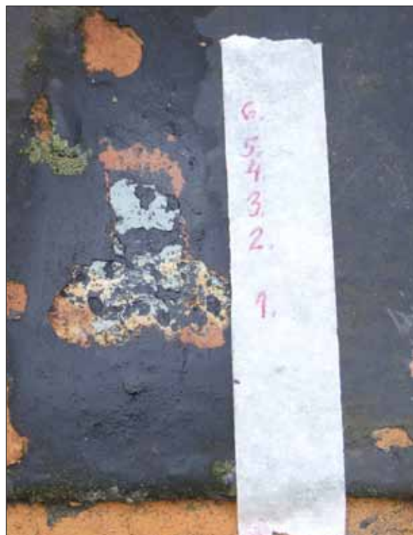
18 Färgtrappan som skrapades fram på den befintliga plåten, norra takfallet (Slm D12-0256).
