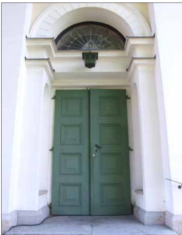
22 Västportalen före målningsarbeten (SIm D12-0260).
