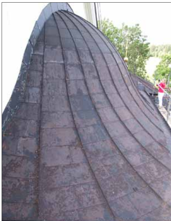
11 Korets plåttäckning, efter blästring av nedre delen. Översta delen är ännu inte rengjord. Fotografi Kjell Taawo, Sörmlands museum (Slm D12-0249).
