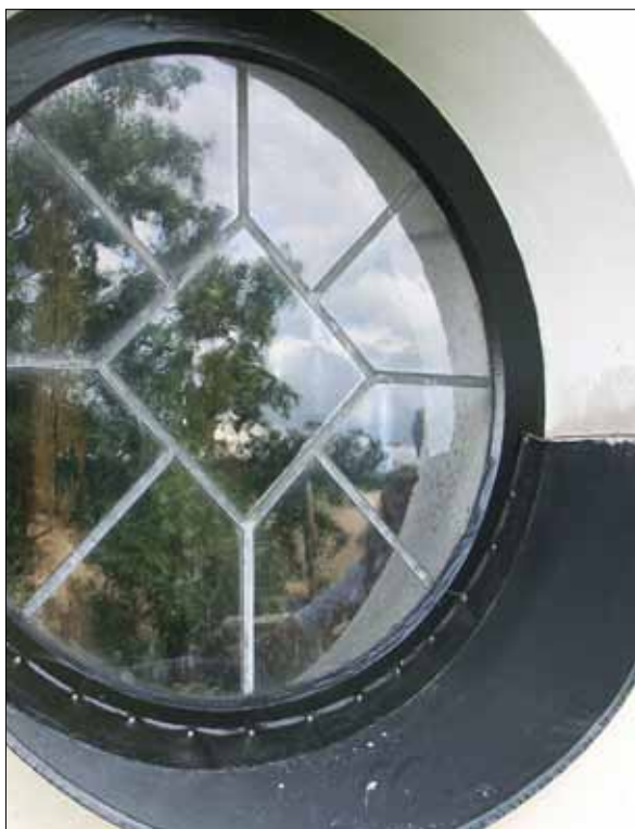
17 Mittrisalitens fönsterbåge på södra fasaden efter åtgärder. Fotografi Kjell Taawo, Sörmlands museum (Slm D12-0255).
