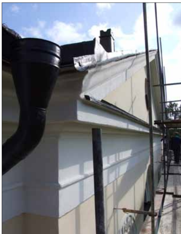
19 Södra fasadens takfot efter putslagningar (Slm D12-0257).
