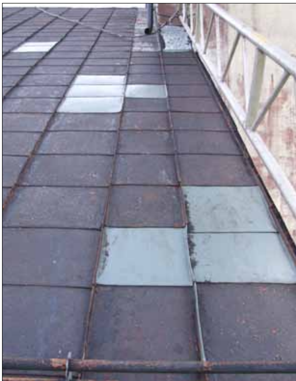
21 Västra delen av norra takfallet efter byte av vissa genomrostade plåtar. Fotografi Kjell Taawo, Sörmlands museum SIm D12-0259).
