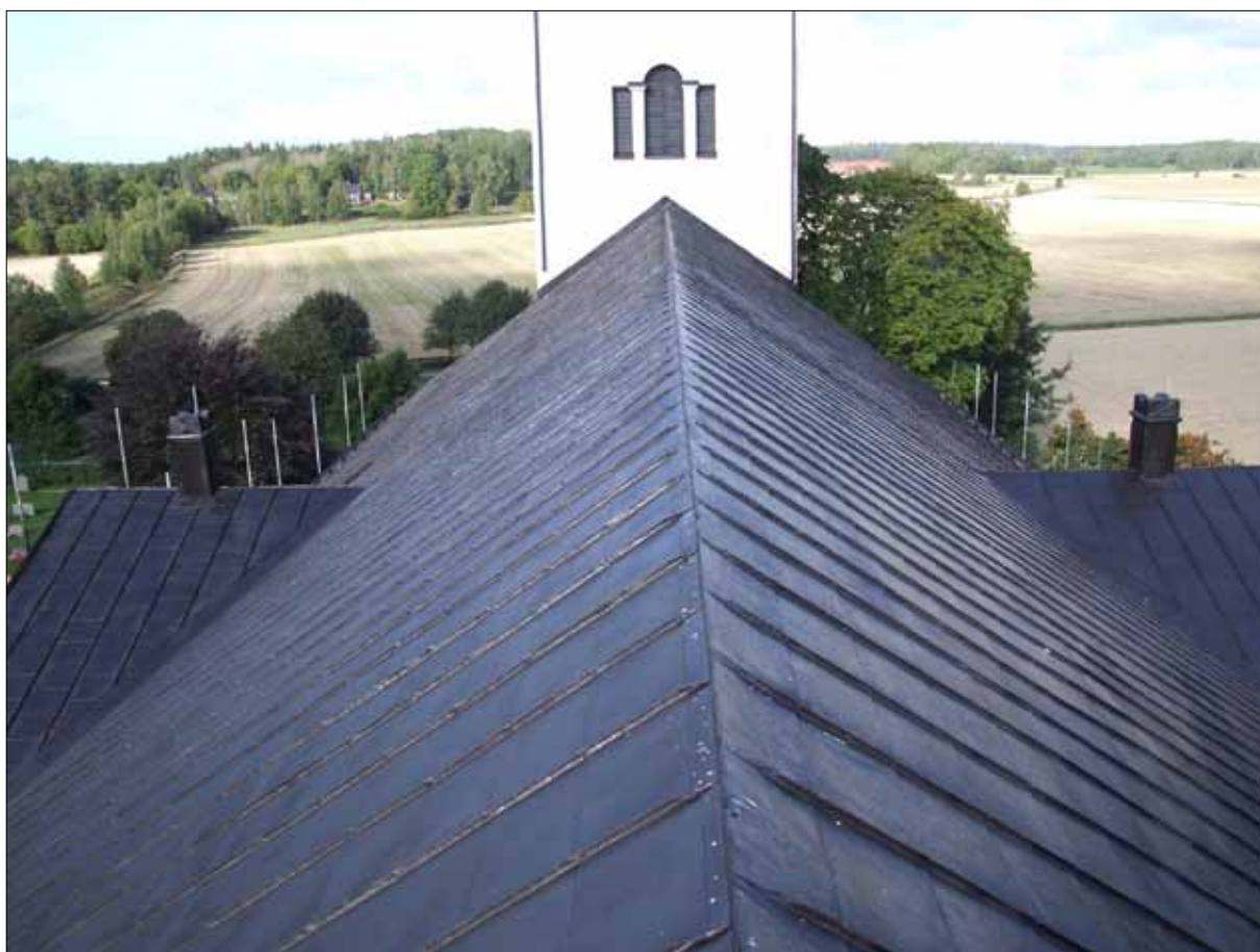
24 Kyrktaket sett mot väster efter arbeten. Fotografiet taget vid slutbesiktningen 4 september 2008 (Slm D12-0262).
