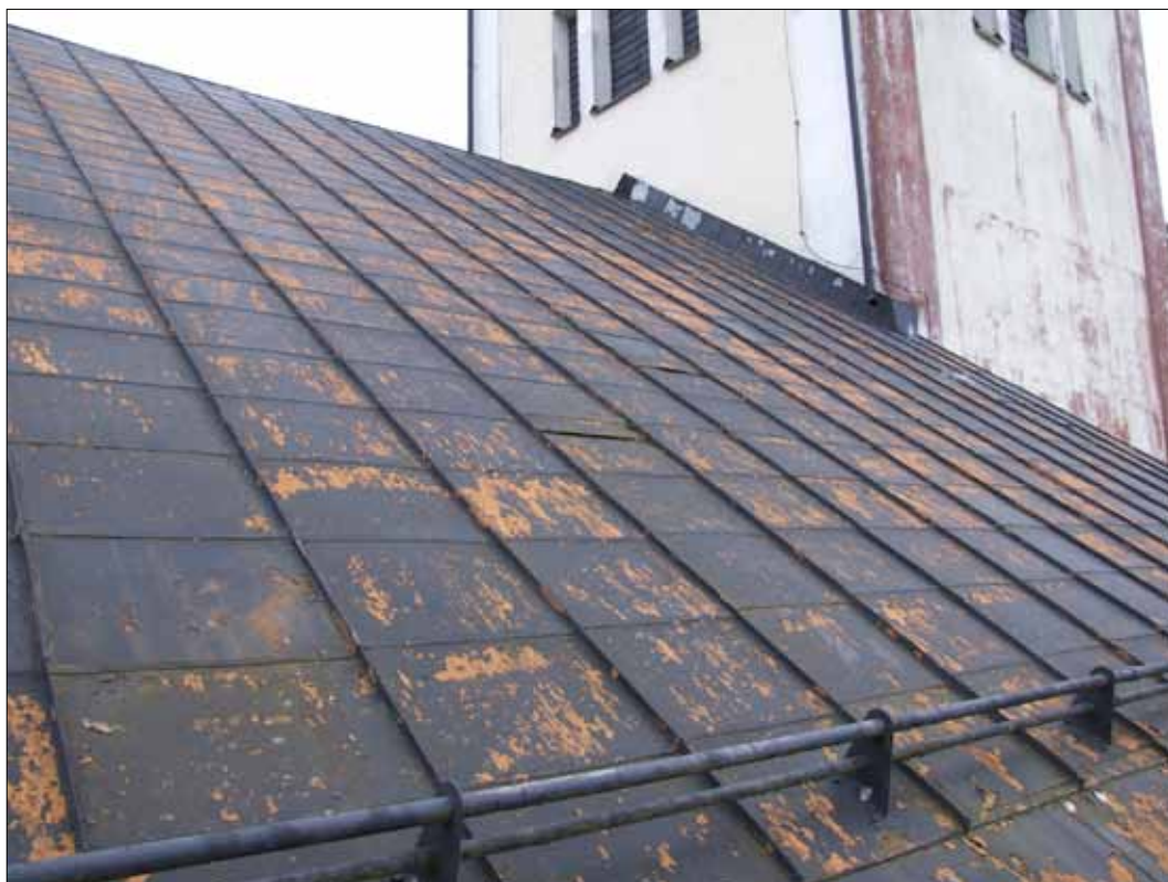
5 Del av norra takfallet före arbeten påbörjades (Slm D12-0243).
