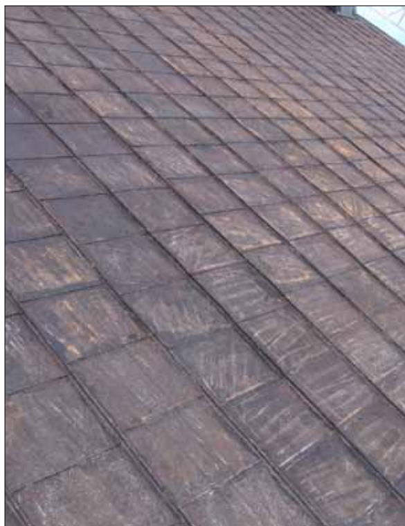
12 Del av norra takfallet efter våtblästring och skrapning (Slm D12-0250).
