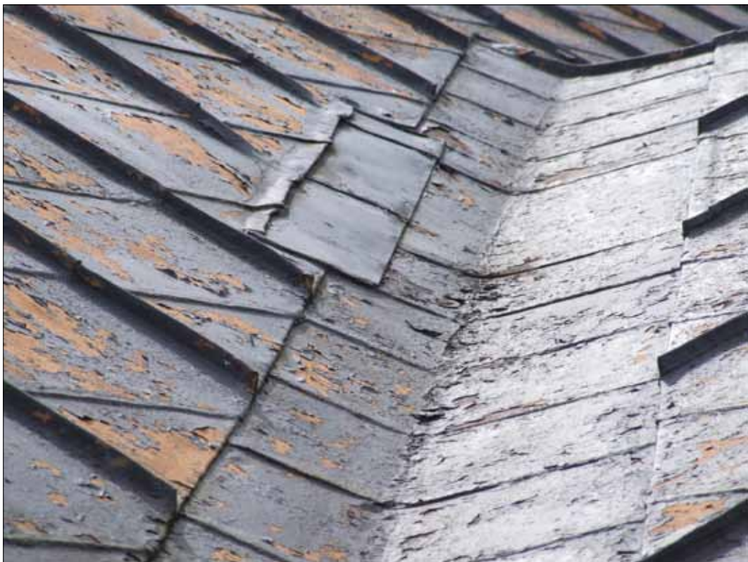
8 Detalj av vinkelrännan mellan norra takfallet och mittrisaliten (Slm D12-0246).
