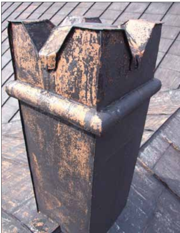
15 Skorstenen vid södra mittrisaliten efter rengöring. Fotografi Kjell Taawo, Sörmlands museum (Slm D12-0253).
