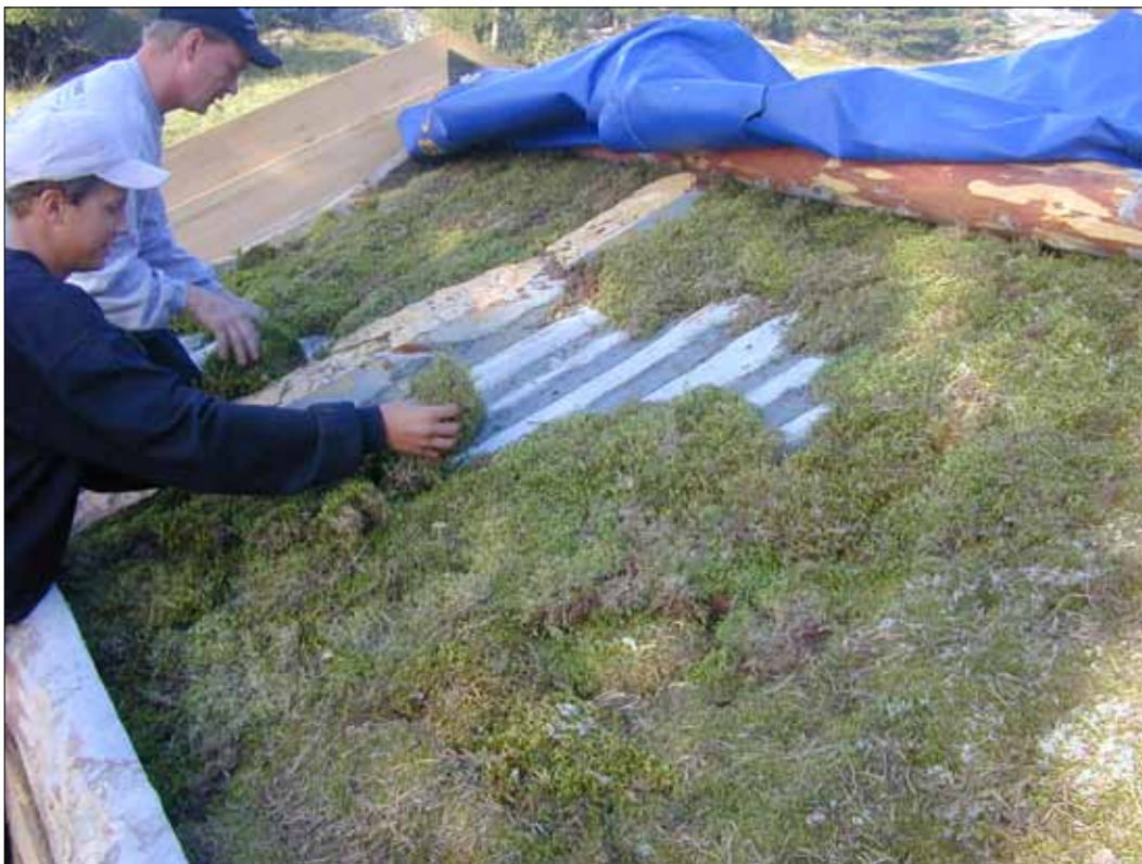
10 Husmossa läggs på plats ovanpå de kluvna rundslanorna och blåleran. I bild syns Markus Berggren och Dick Berggren (Slm D12-0438).
