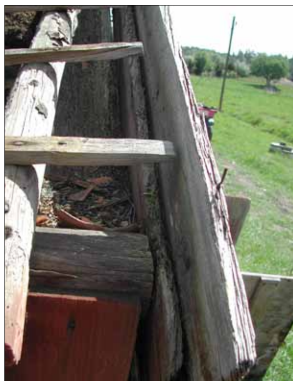
12 Bärläkten var spräckt och spikad med handsmidd spik i ströläkten som bestod av granslanor. Före åtgärd (Slm D12-0440).
