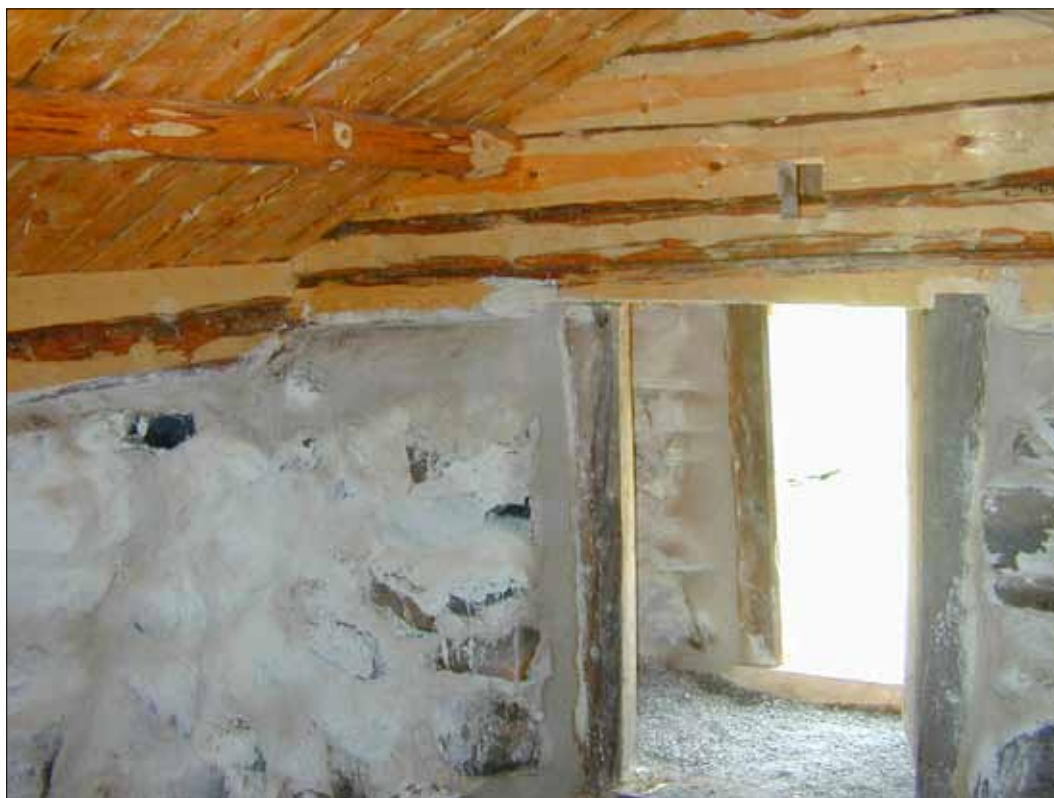
14 Murverket slammades invändigt med tunn puts och ströks med vit kalkfärg (Slm D12-0442).
