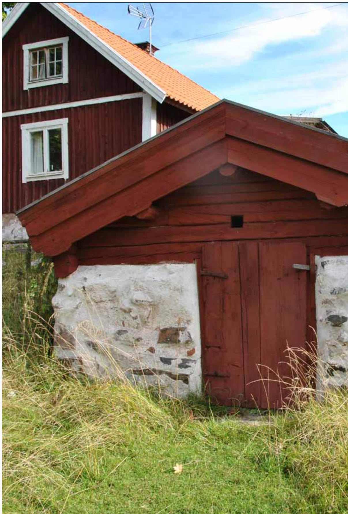
16 Jordkällaren i september 2012. Vänstra vindskivan kunde sparas (Slm D12-0444).
