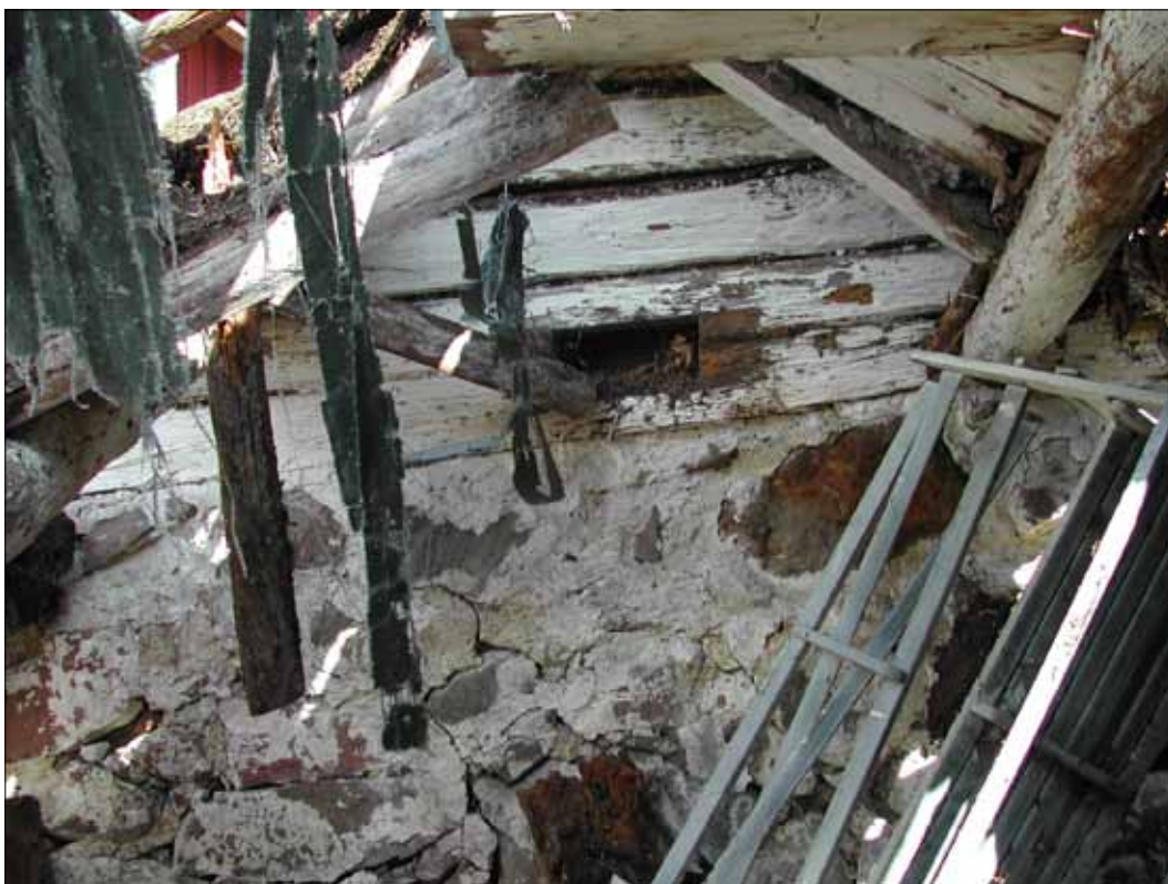
9 Jordkällaren sedd mot öster före åtgärd i maj 2002. I gaveln fanns sedan tidigare en rektangulär öppning, som nu rekonstruerades. (Slm D12-0437).
