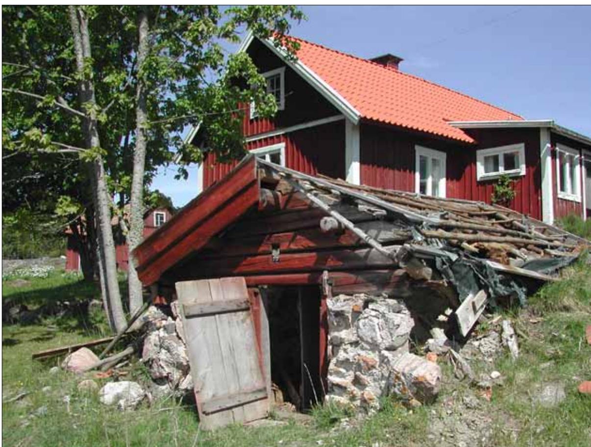
2 Jordkällaren vid Kullbo före åtgärder i maj 2002 sedd från sydväst. I bakgrunden syns mangårdsbyggnaden från 1700-talet, dock ombyggd i senare tid (Slm D12-0432).
