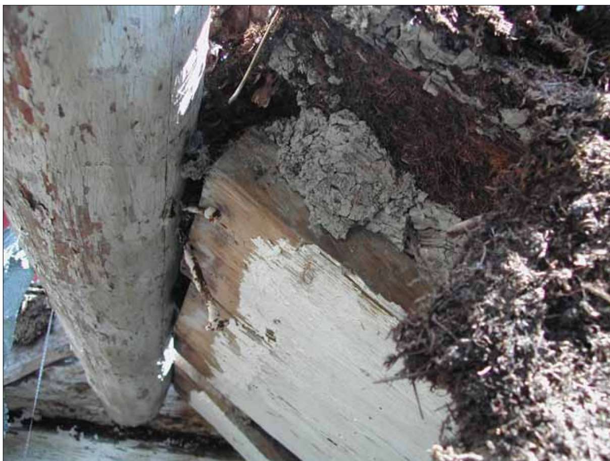
6 Detalj av den undre kroppåsen och undersidan av de spräckta rundslanorna. Till höger om åsen syns leran och husmossan. Före åtgärder 28 maj 2002 (Slm D12-0434).
