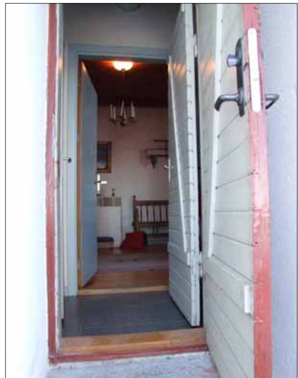
7 Vy från sakristians ingång i norra muren före åtgärder (Slm D12-0162).
