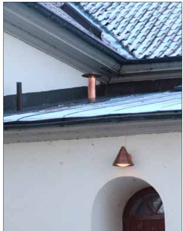
26 På yttertaket placerades en ventilationshuv för frånluftsventilationen. Även ytterbelysningen är ny (Slm D12-0181).
