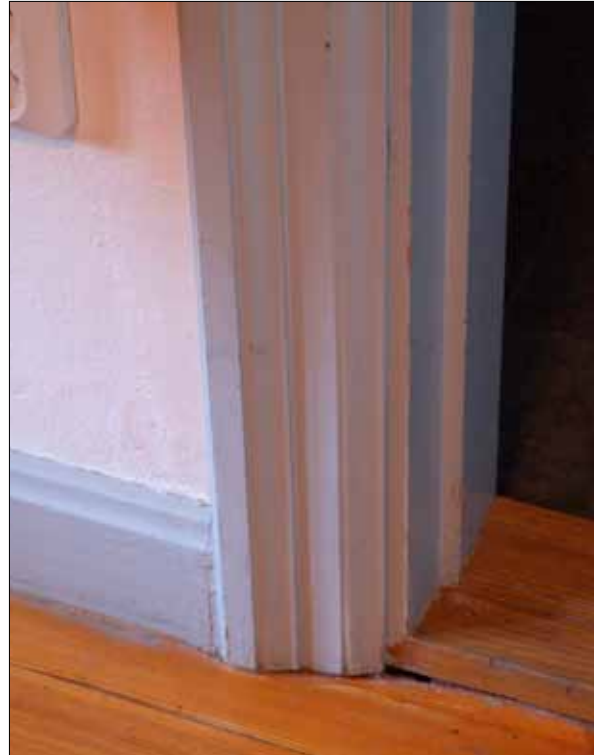
19 Detalj av äldre golvsockel och dörrkarm. Sockeln behövs och dörrkarmen lades undan (Slm D12-0174).
