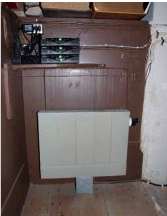
20 Äldre radiator placerad på predikstolskorgens insida. Radiatorn togs nu bort (Slm D12-0175).
