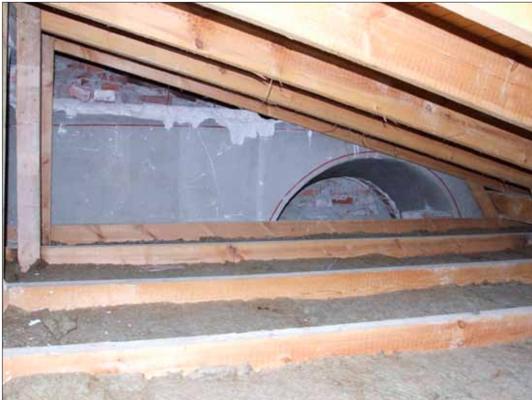
29 Vindsbjälklaget från 1962-63, med äldre målning och delvis igenmurad fönsteröppning. (Slm D12-0184).
