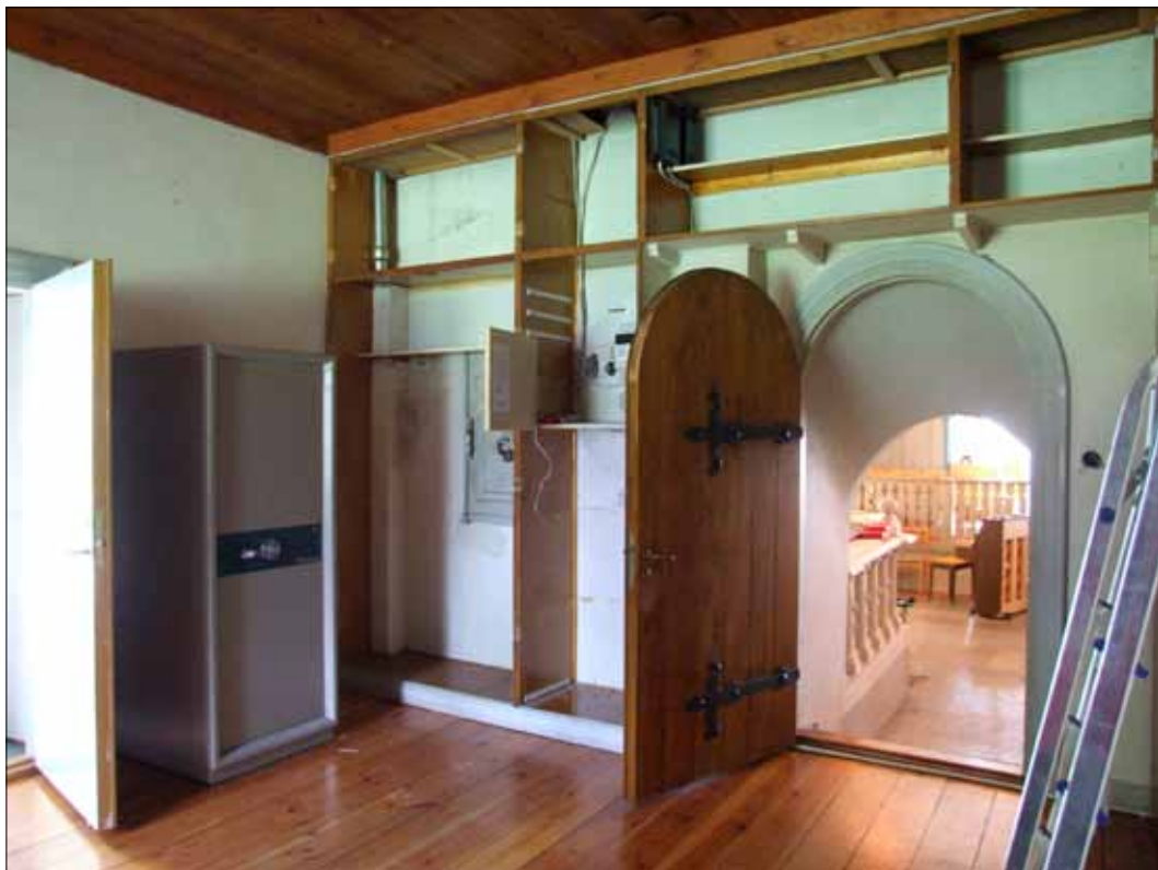
22 Arbeten har påbörjats. Vy mot söder. Skåpluckor och lådor har tagits bort (Slm D12-0177).
