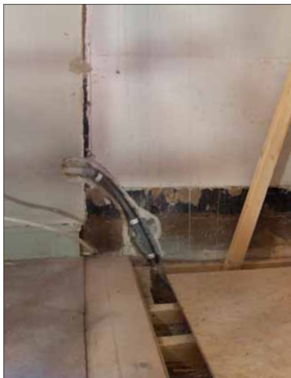
28 Vid norra muren, där skåpet hade stått, var väggen svartmålad. Här har tidigare en eldstad stått. Golvet kompletterades (Slm D12-0183).
