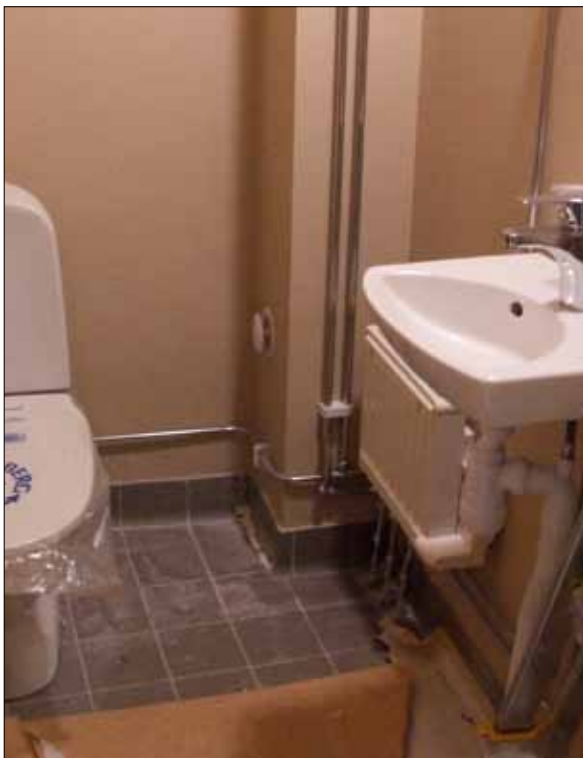
25 WC efter åtgärder. Till höger syns luftventilen, vars kanal mynnar ut på andra sidan väggen, bakom textilskåpet (Slm D12-0180).
