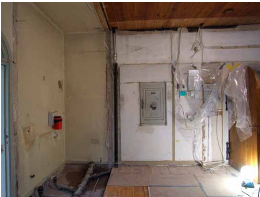
23 Sakristian sedd mot söder under arbeten. Värdeskåpet fick sitta kvar bakom den nya skåpsinredningen. Golv och tak kompletterades där skåpen tidigare stått. Grön färgsättning av väggarna från 1905-1906 ansas på väggytor vid skåpens infästningar (Slm D12-0178).
