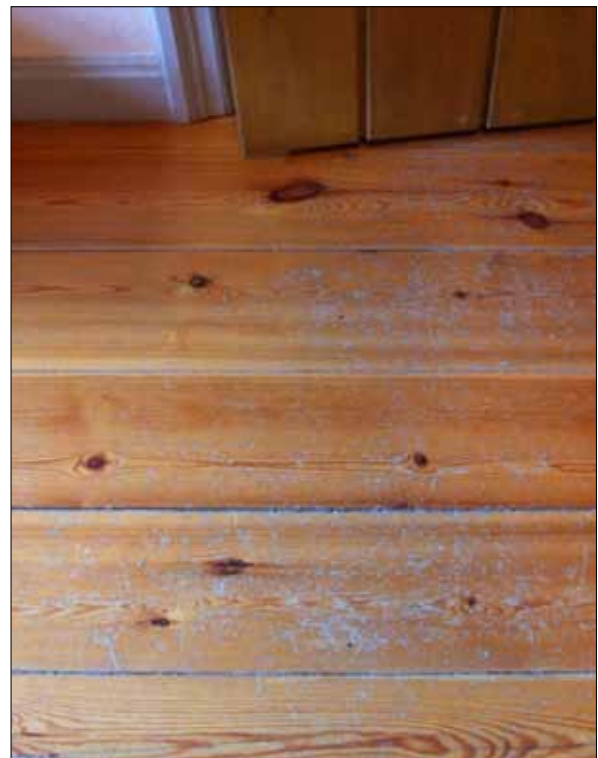
17 Trägolvet i sakristian var lackat och relativt slitet och slipades därför nu (Slm D12-0172).
