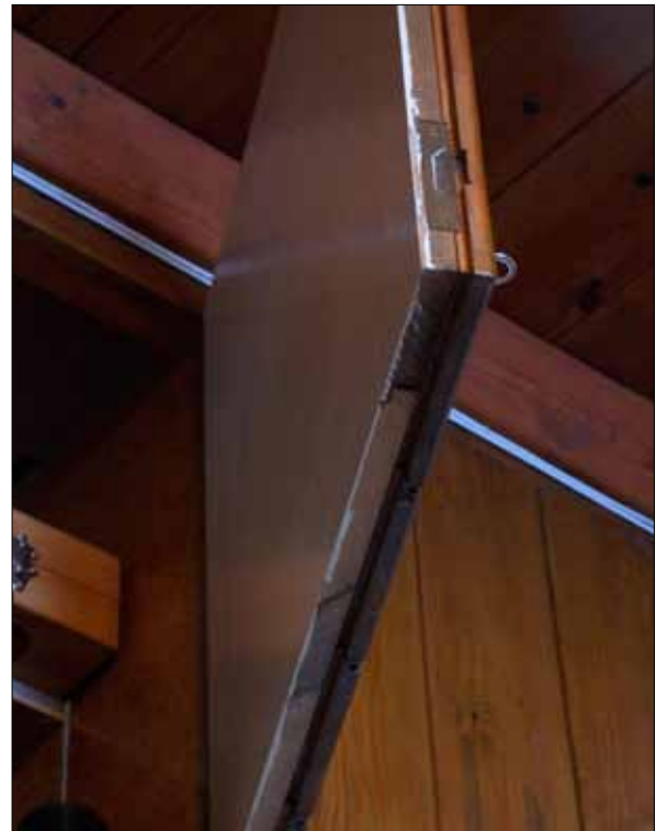
15 Detalj av övre skåpsluckorna vid södra väggen. Virket var spontat (Slm D12-0171).
