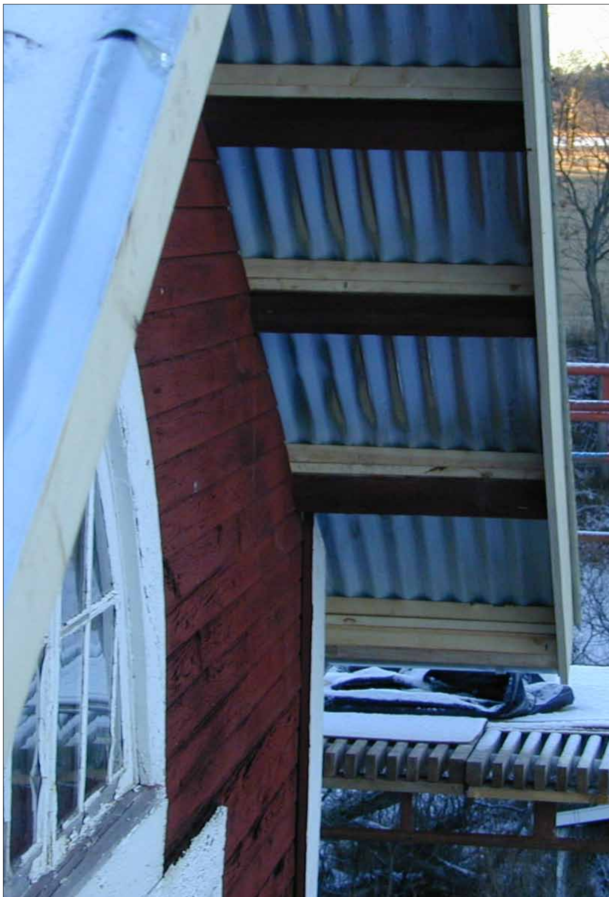
15 Södra gaveln efter åtgärd. Takfotstassarna har lagats och den korrugerade plåten är synlig under gavelutsprånget som tidigare, december 2002 (Slm D12-0393).
