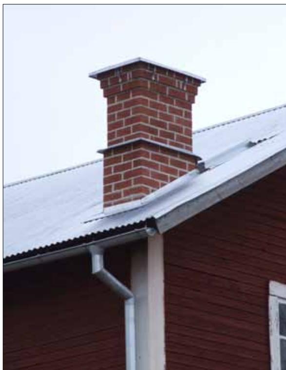
13 Skorstenen efter ommurningen. Krönet rekonstruerades efter äldre fotografier. Fotografi Eva Wockatz (Slm D12-0391).
