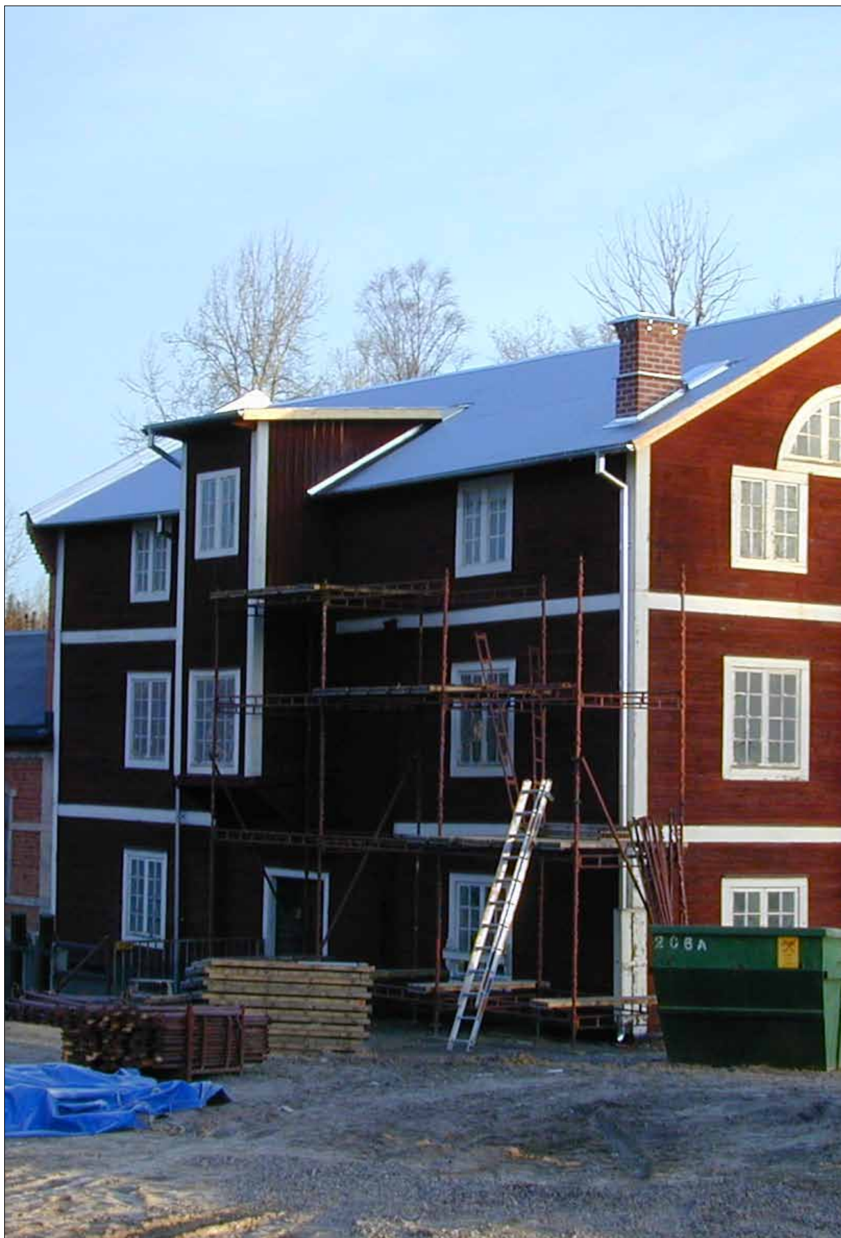
16 Kvarnbyggnaden vid slutbesiktningen den 23 januari 2003 (Slm D12-0394).
