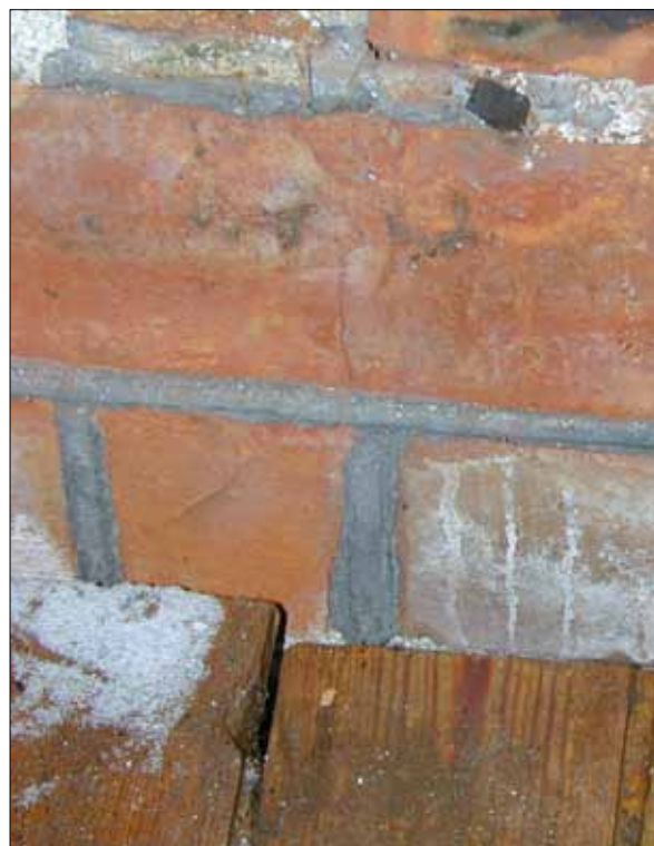
9 Fogarna var utförda som rundfogar och fogbruket var något gråfärgat, november 2002 (Slm D12-0388).
