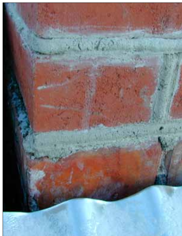
14 Nya fogar utformades som rundfogar (Slm D12-0392).
