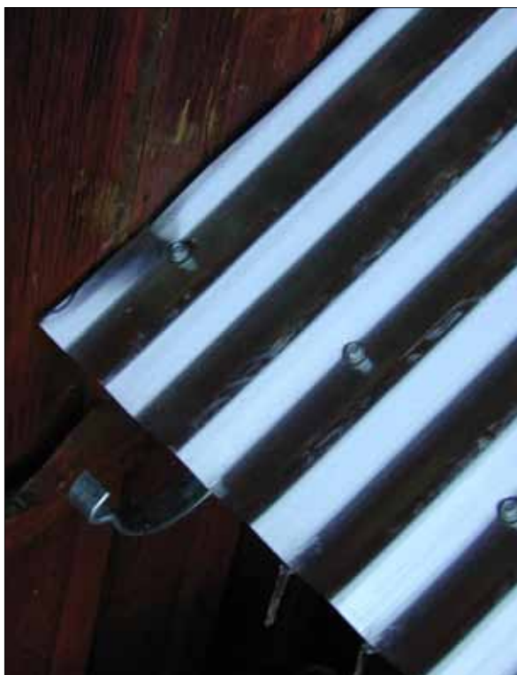
12 Plåten skruvades fast med farmarskruv (Slm D12-0390).
