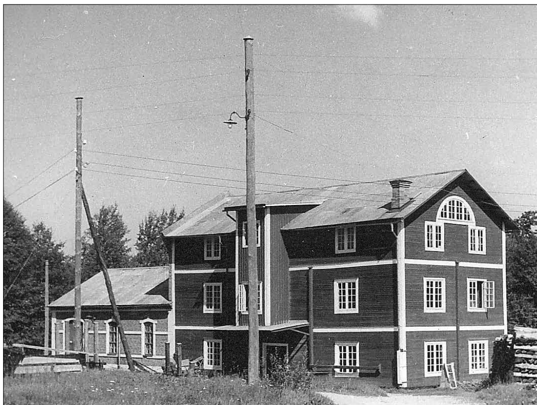
4 Kvarnbyggnaden sedd från sydväst år 1950. Till vänster syns den lägre kraftstationen. Kvarnen har plåttak och skorstenen är utkragad. Fotografi Sörmlands museum, okänd fotograf. Från Sveriges städer och samhällen. (Slm M004649).
