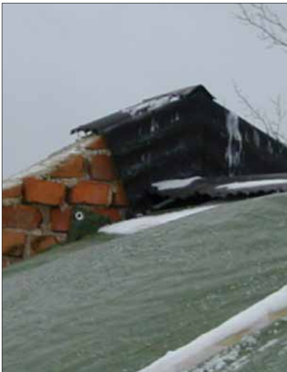
6 Murkrönet i norr var täckt med plåt, november 2002 (Slm D12-0385).
