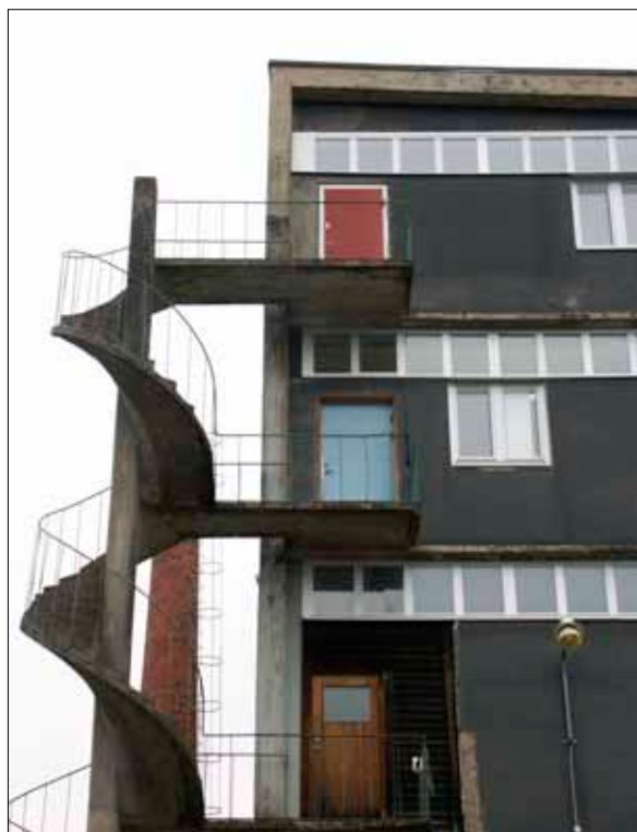
Detalj av spiraltrappan med pelaren i mitten och de utanpåliggande bjälklagen med sirliga järnräcken.
