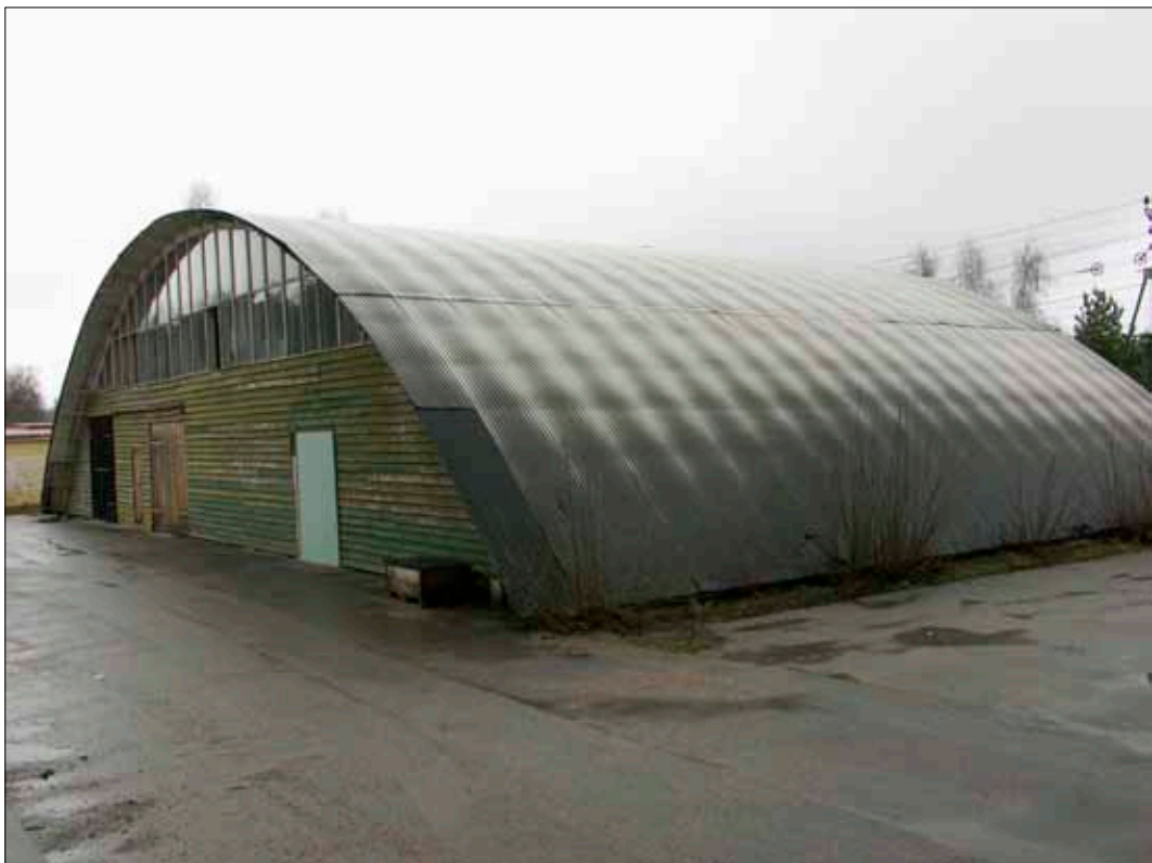
Den välvda lagerlokalen av trä och glas är en viktig del i detta fabrikskomplex som tillkom samtidigt för tvålproduktionen. Den gröna färgen har varit densamma som på fabriken.
