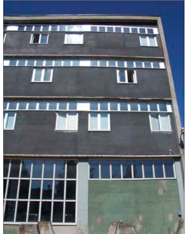
Olika färgfält på den sydöstra fasaden har behållits vid restaureringen.
