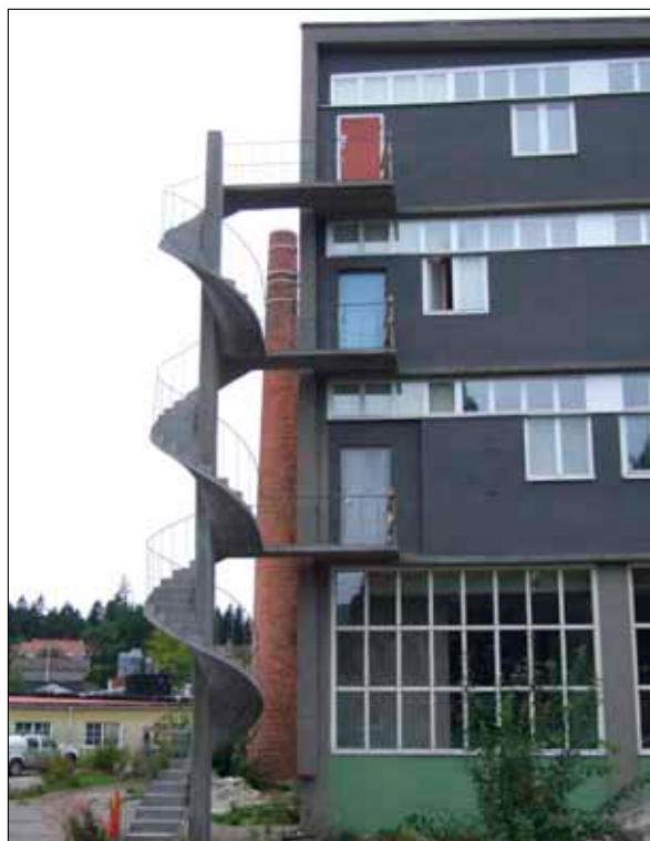
Här är den skulpturala spiraltrappan restaurerad. Den har stor betydelse för helhetsintrycket på fabriksbyggnaden.
