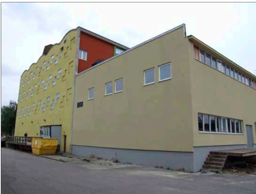
Här har tillbyggnaden tilläggsisolerats och målats i särskiljande färg från huvudbyggnaden, vars gavelkulörer antyds ovanför. Kraftfull rödbrun ton och grön som fanns under den svarta just här.
