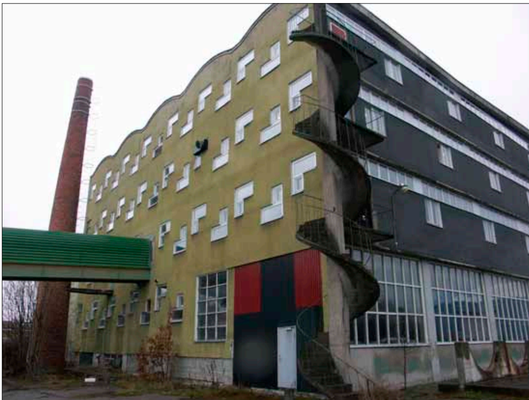
Arkitekternas lekfulla fasad av lättbetong med böljande avslutning vid taket, olikfärgade fasadväggar, trappan som utsmyckning och de olika typerna av fönster. I den ljusaste delen av bottenvåningen skedde tvåltillverkningen i Bergströmska fabriken.
