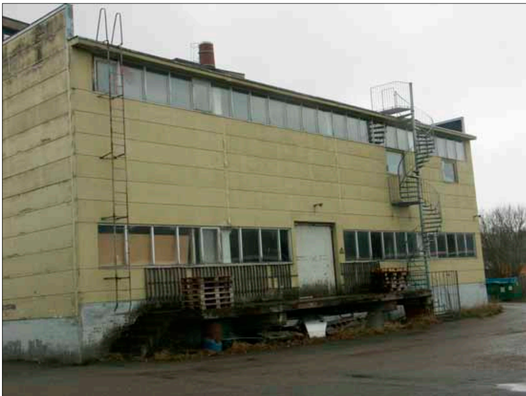
Tillbyggnaden nordväst om fabriken. Fönsterbanden gör en återkoppling till Erskines byggnad.
