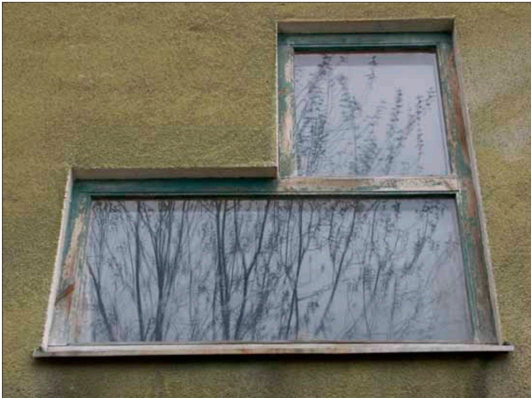
Ralph Erskines originalfönster av trä som har dominerat två av fasaderna.
