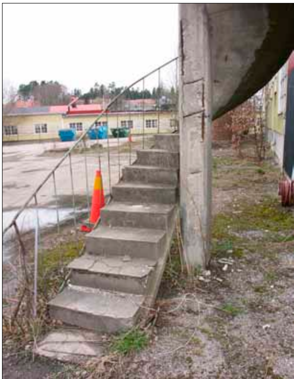
Spiraltrappans nedre del som var söndervittrad.
