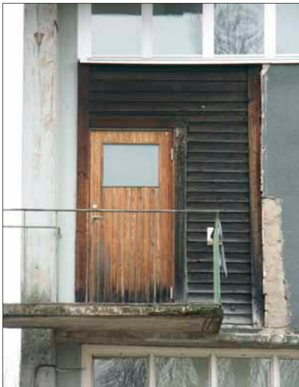
Originalutförandet med dörr till trappavsats på andra våningen. Vägparti av brädor på förvandring är ett återkommande tema på lagerbyggnaden och kontoret.
