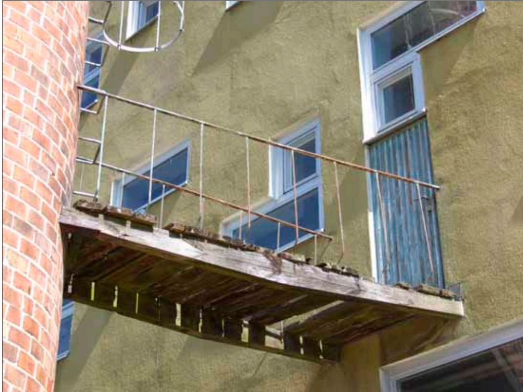
Gångbryggan mellan fabriken och skorstenen i väster och originaldörr av trä.
