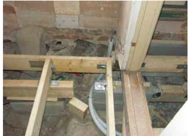
Matsalens och salongens bjälklag har förstärkts med moderna material och tekniker. En vertikal stålpelare har monterats i väggen vid dörren mellan matsal och salong för att bära upp förstärkningar i vindsbjälklaget.
