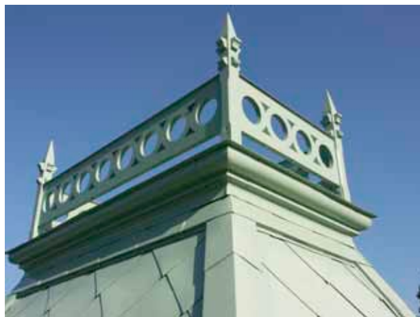
Krönet på ett av tornen. Den övre delen är av trä. Detaljkedomen i plåtarbetet har följts från originalet.
