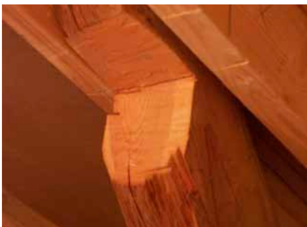
Ett exempel på brysk avsågning av högben för att flytta ut ny skåpsvägg mot yttervägg.
