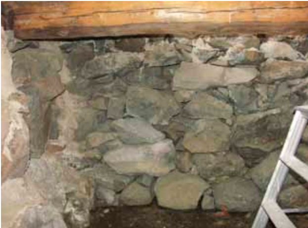
Under matsalens golv finns en kallmurad källare, som sannolikt hör samman med timmerbyggnaden som stod här även under uppbyggnaden av det nya huset.
