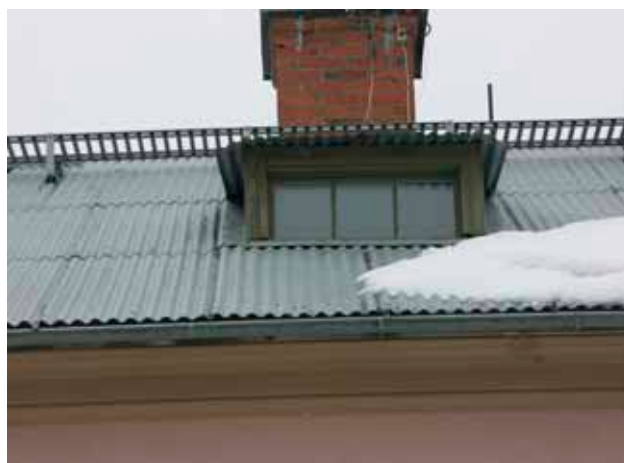
Takkupa i väster. Korrugerad plåt på sadeltaket i mitten.
