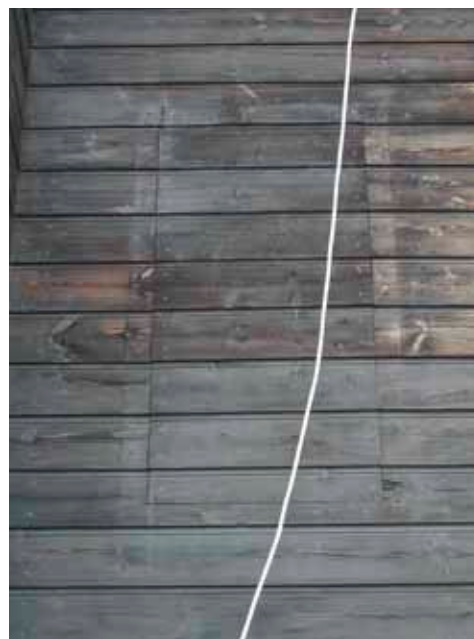
Ett tidigare igensatt fönster på baksidan av ateljén.
