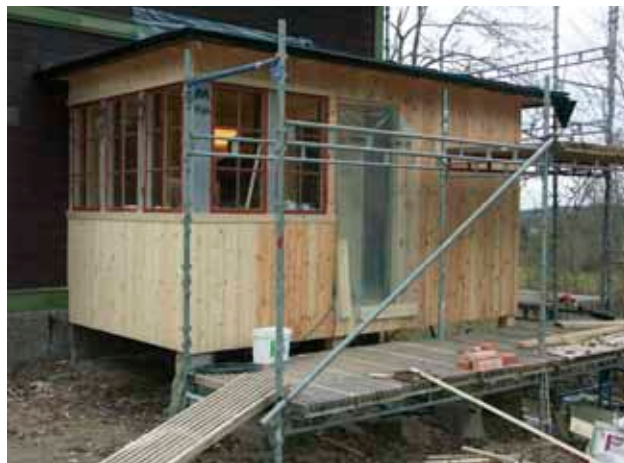
Verandautbyggnaden går ut mot den bakre ateljéväggen. Ytterpanelen är fasspontade brädor som i original.
