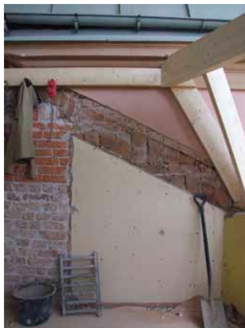
Gavelrummet i söder under ombyggnad. Skillnaden i tak-höjd syns mellan det beigeputsade fältet och det nya virket.
