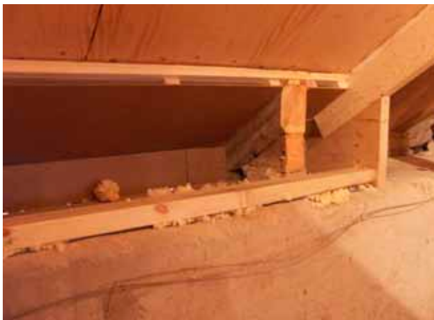
Högben och hanbjälke är borta. De nya delarna i konstruktionerna dominerar.
