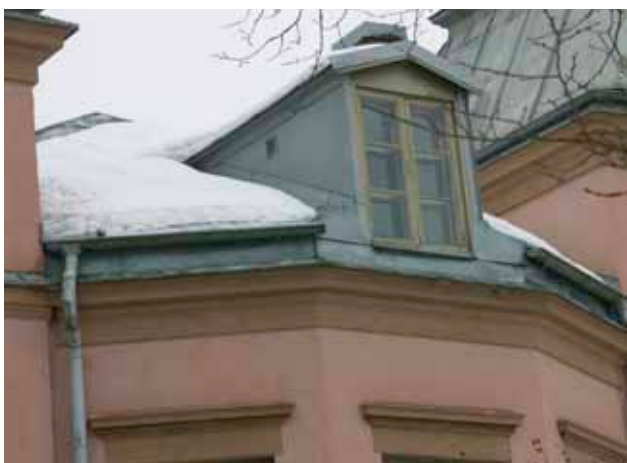
Gavelpartiet i norr med takkupa kommer att byggas om med höjning av gaveltaket. Detta har skett i söder.
