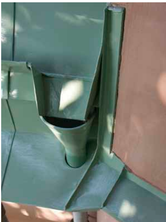
Många detaljer i plåtarbetet. Kulören har valts med omsorg för att harmoniera med den rosa kulören på fasaden och med den mustigt gula på utsmyckningarna.
