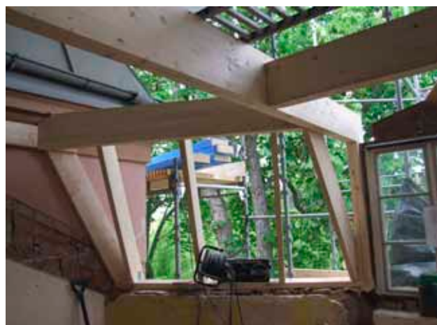
Det nya gaveltaket under uppförande.
