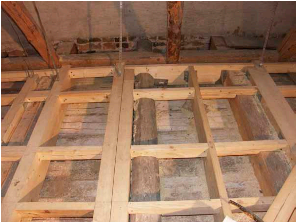
Bjälklagsförstärkning i vindsvåningen. Innertakvirket är spräckt och har profilerad kant samt vit limfärg på ovansidan, vilket tyder på återanvändning. Samma profil återfinns synlig i kökets tak. Källa Peter Alaton.
