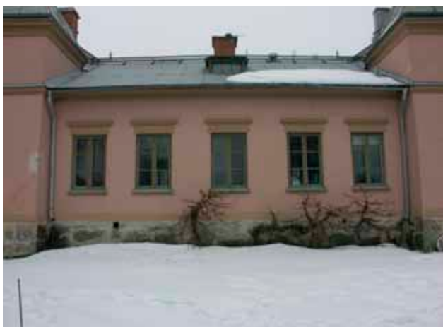
Takkupan mot trädgårdssidan i väster var låg och enkel, närbild på sidan 7. Tre nya takkupor är byggda.
