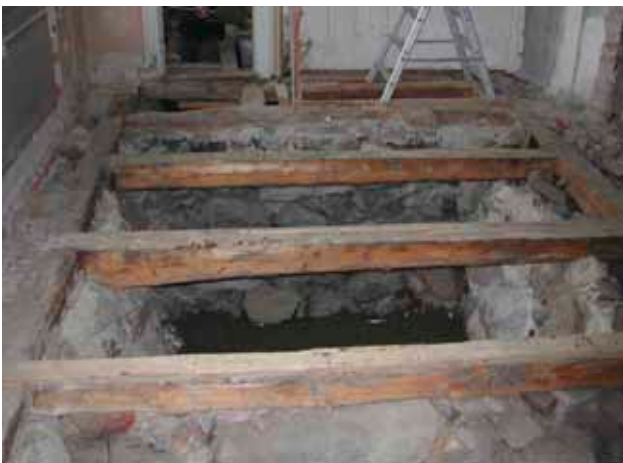
Matsalens golvbjälklag och den kvadratiske källaren. Dörröppning leder till salong och köket ligger till höger.
