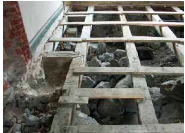
Salongens bjälklag med berg och sten under. Bärninornas riktning är öst-väst. Till vänster syns spår efter bortriven öppen spis, som byggdes av förra ägaren 2005.
