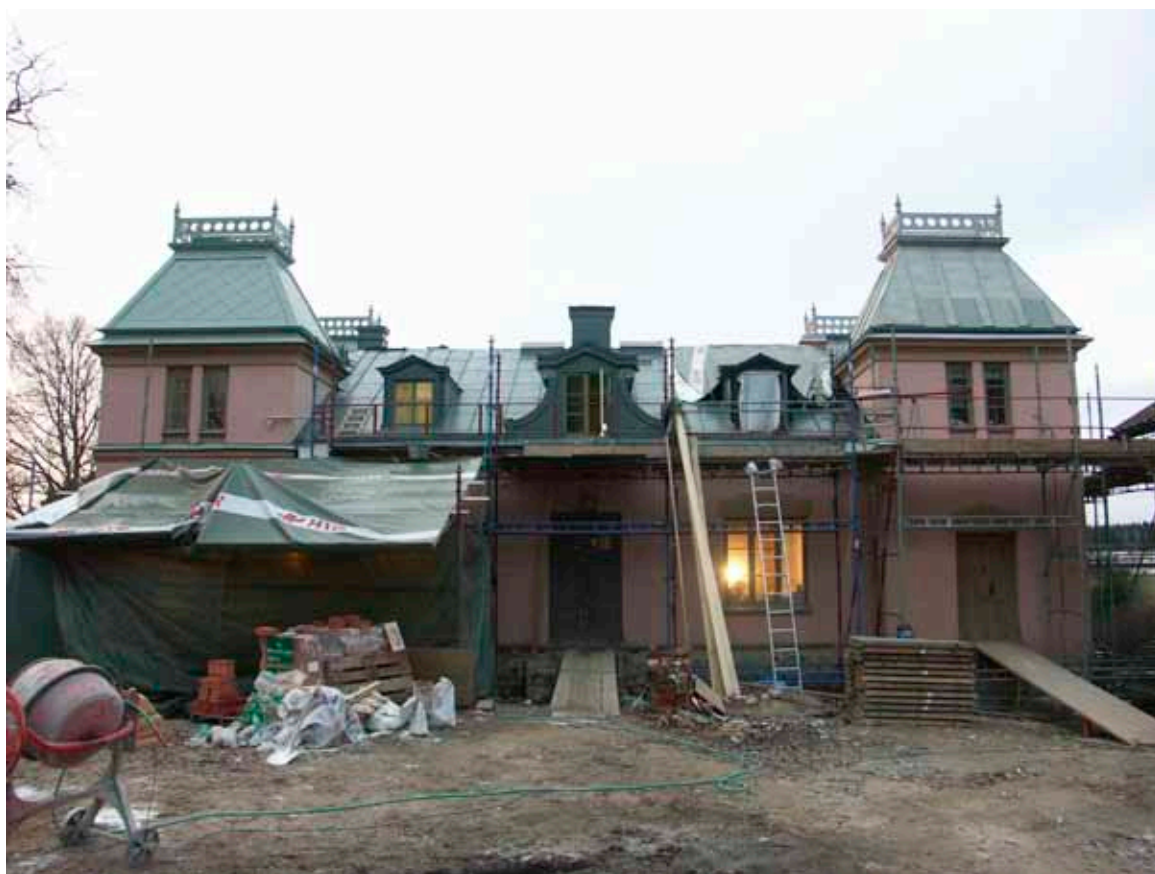
Huvudbyggnadens entrésida med två nya takkupor intill mittenkupan. Nylagd plåt på taket fram till det högra tornet samt mindre plåtskivor i rombisk form på de två tornen till vänster, d v s i söder.
