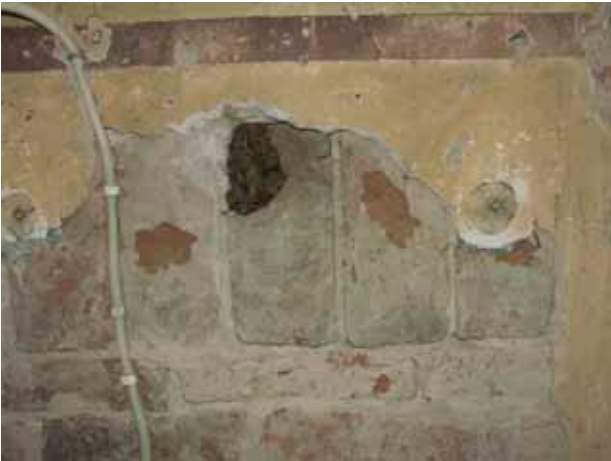
Tegelvägg i öster bakom köksskåp med lindrevsfylld sten. Den Langletska, kraftfulla, gula kulören återkommer på flera väggpartier liksom den rosa tonen som i bården högst upp.
