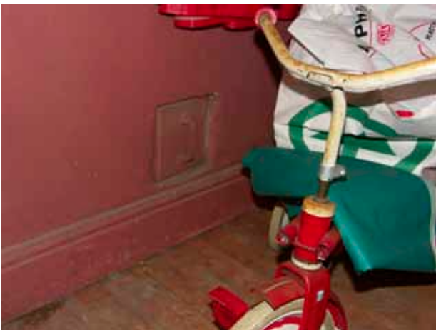
Farstun i öster med rosaröda väggar som bröstning före upprustningen.
