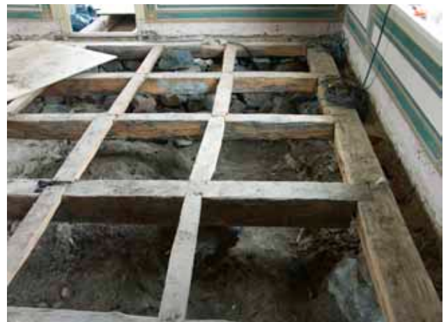
Salongens bjälklag utmed den västra väggen. Bindbjälken till höger har sågats bort för att ge plats för konvektorlådor till uppvärmningen. Därmed kunde radiatorer uteslutas.
