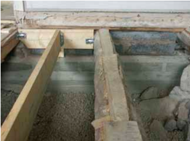
I matsalen har moderna tillägg gjorts i bjälklaget. En gjutning har också gjorts under kökswäggen. Singel ligger i grunden.
