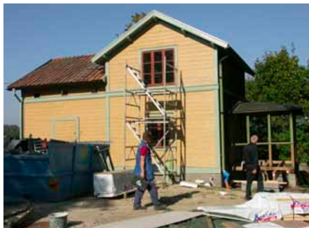
Första gula strykningen på ateljén gjordes i september av målare Gunnar Bjärkesjö, Björssons Måleri. Engelskt röda fönsterbågar och grågröna accenter läggs till. Tidigare var det något mörkare grön kulör.
