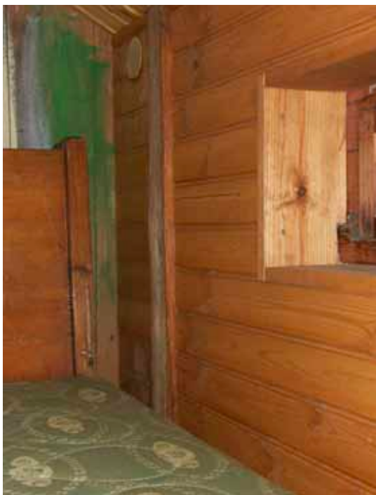
I verkstaden på övre våningen har tilläggsisolering gjorts inåt och pärlspontpanel från vinden i huvudbyggnaden satts upp.
