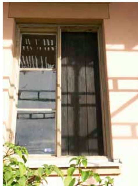
Blindfönstret i väster på huvudbyggnaden i den lilla passagen mellan salong och matsal. Idag är fönstret ombyggt till dörr.
