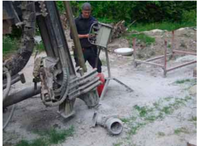
Borrax bergvärmeborrning av fem hål framför entrén.
