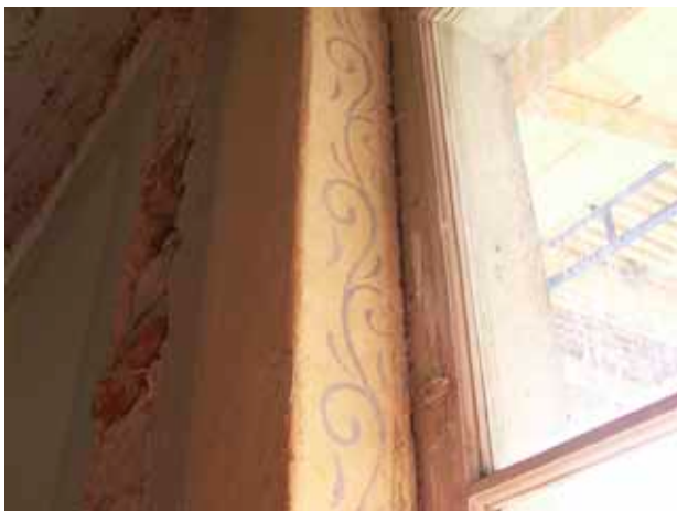
Handkammarens dekormåleri på puts vid fönster med den ena bågen som blindfönster. Fönstret har nu byggts om till dörr.
