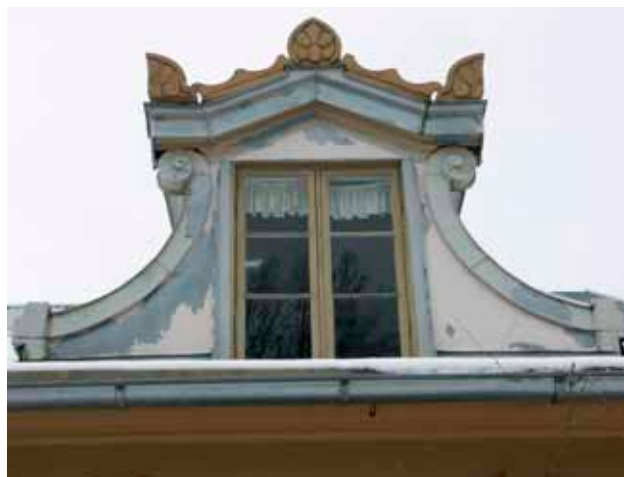
Den gamla takkupan på långsidan i öster ovanför entrén.
