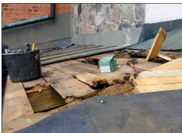
Figur 9. Pågående reparationsarbeten på pannrummets tak.
