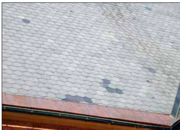
Figur 13. Utbytta skifferplattor på kyrkans tak.
