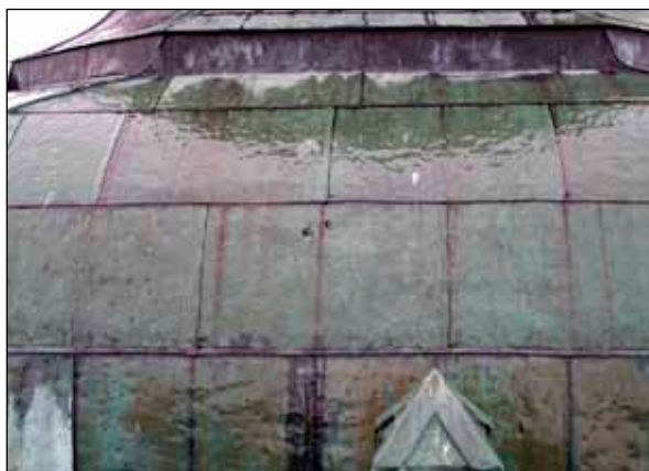
Figur 6. Tornhuvens hade en mindre mekanisk orsakad skada i form av två små hål i plåten.
