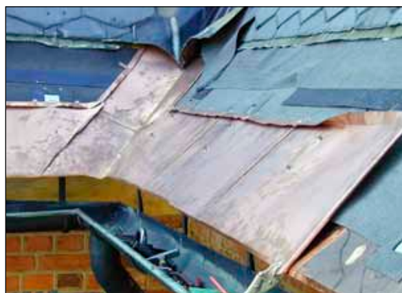
Figur 11. Montering av ny fotplåt.
