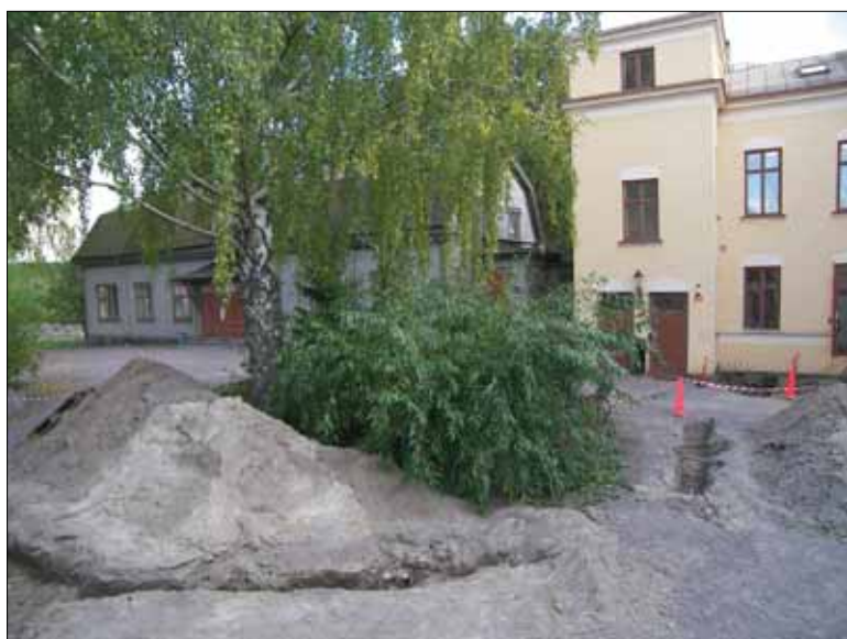
Figur 7. Översikt över schakt 2 mot sydsydost. I förgrunden syns delar av schakt 3. I bakgrunden slottsskolan med schakt 1. Foto: Björn Pettersson år 2011, Sörmlands museum.
