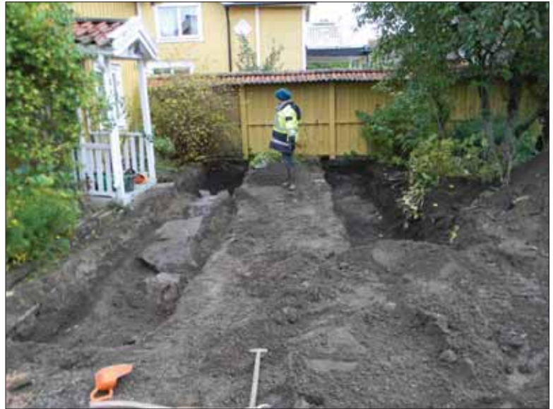
Figur 3. Schakt 1 till vänster i bild med de påträffade syllstenarna synliga framför husets farstukvist. Till höger i bild syns Schakt 2. Bilden är tagen mot söder. Foto: Patrik Gustafsson, 2012, Sörmlands museum.
