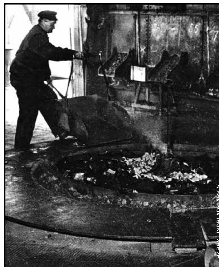
Uppsättaren Karl Karlsson fyller på malm i masugnen från masugnskransen, 1952. Han blandar olika malmsorter och kalk i skopan och varvar det sedan med träkol i masugnen.
