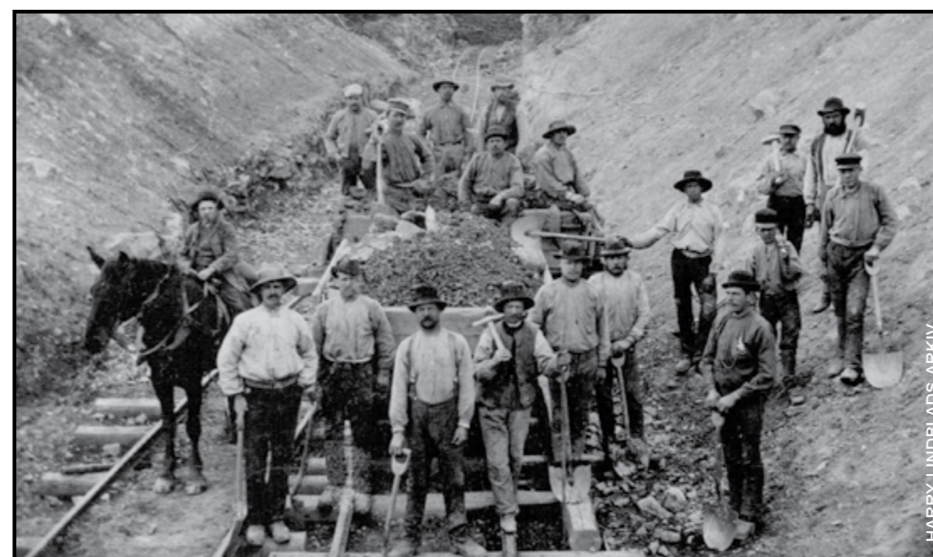
Rallare (järnvägsbyggare) i färd med bygget av Norra Södermanlands Järnväg, 1893. I slutet av 1800-talet reste rallare runt i Sverige och byggde järnvägar. Rallarna kom ofta från södra och mellersta Sveriges landsbygd.
