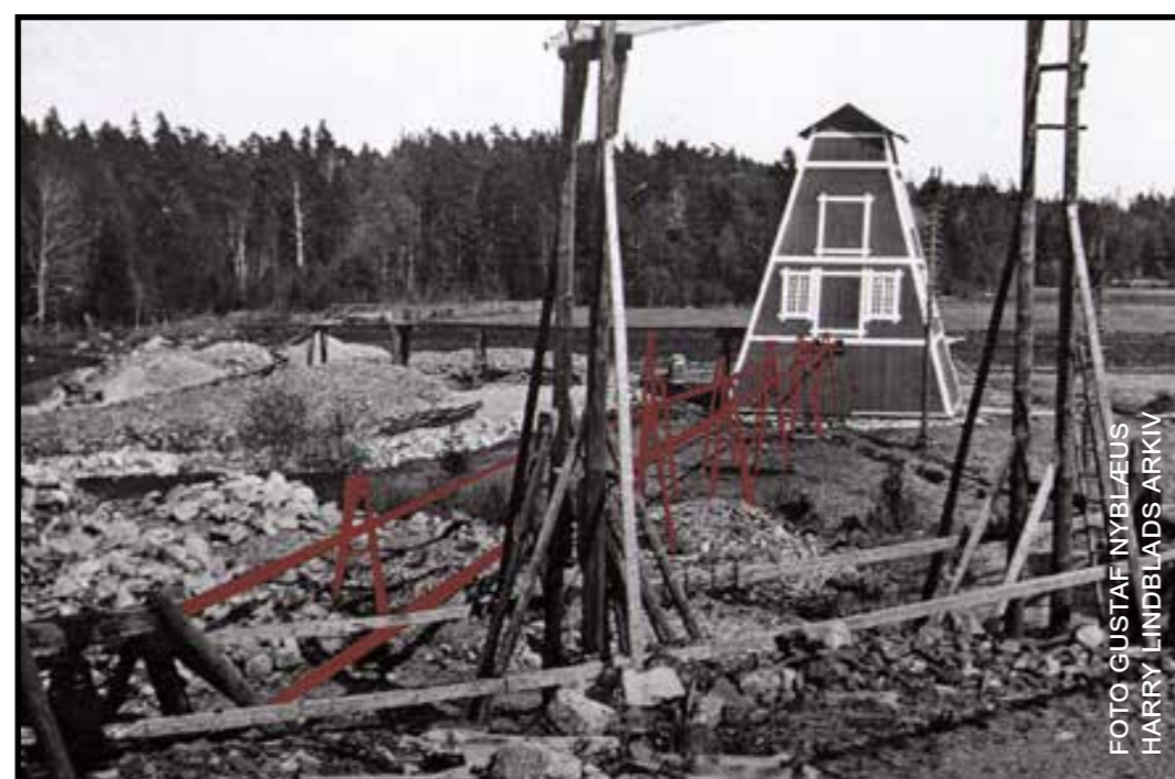
Gruvlaven vid Bredsjönäs, 1917. Stånggången som drev pumparna vid gruvan är rödmarkerad på fotot.
