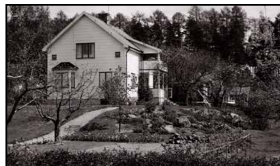
Bengtssons hus på Nyblaeus väg, 1968. Huset har tilläggs-isolerats och fått en ny panel med eternitplattor.
