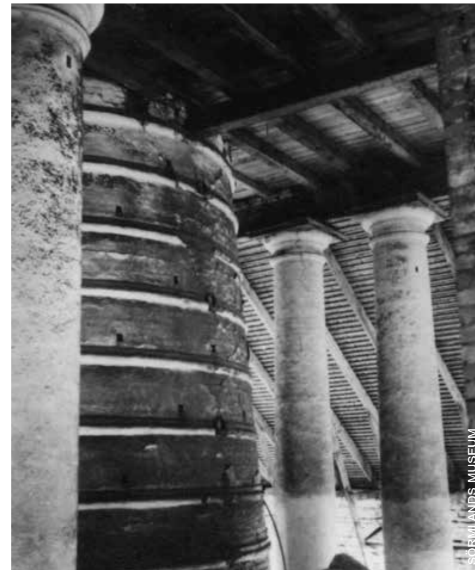
Interiören är ett imponerande byggnadsverk med pelare som bär upp konstruktionen och med ugnen i mitten.
