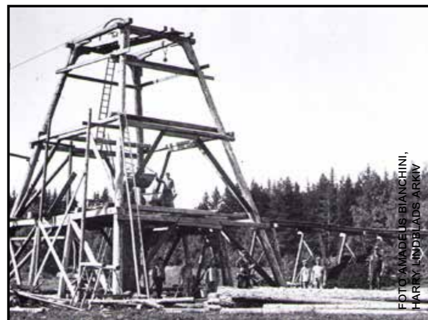
Nytt lavtorn byggs i Bredsjönäs. Till höger syns stånggången till pumparna.
