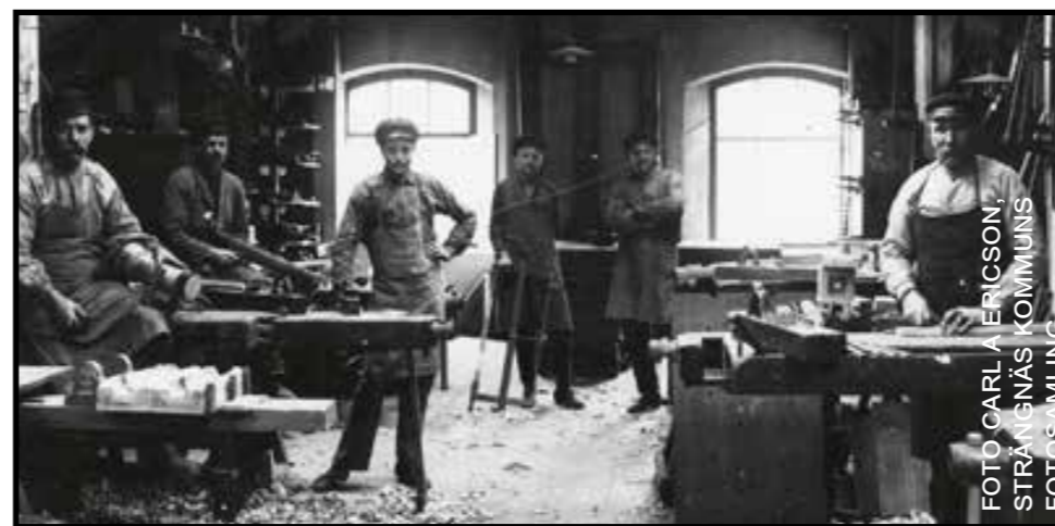
Modellsnickeriet, 1922. Här tillverkades modeller till gjuteriet. I gjuteriet gjordes sedan formar som järnföremålen göts i. Fr v Anton Eriksson, Gustav Larsson, Nils Svensson, Edvin Södersten, Ragnar Insulander och Isak Håkansson.
