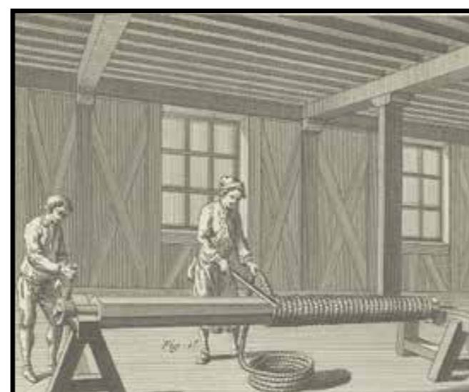
Bildsviten visar tillverkning av en gjutform för kanongjutning. Kanonens kärna framställdes genom att man lindade ett halmrep runt en stock.
