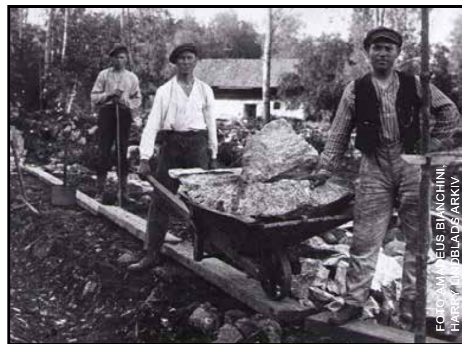
Järnvägen byggs mellan Åkers Styckebruk och Skottvångs gruva, 1918. Fr v Ragnar Karlsson, Arvid Axelsson och okänd.
