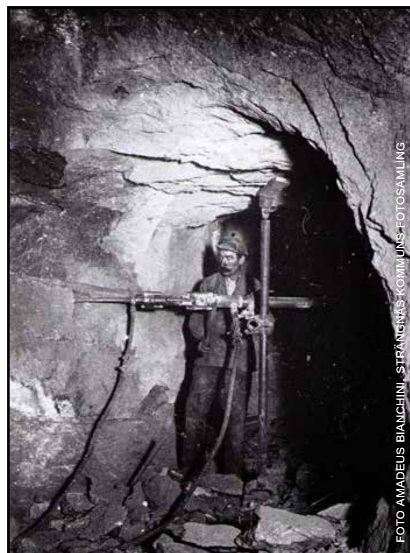
Lasse i Hagen med pneumatisk pelarborr.
