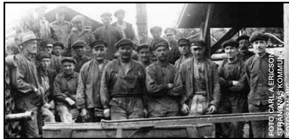
Arbetare vid Åkers Styckebruks rörgård, 1927.
