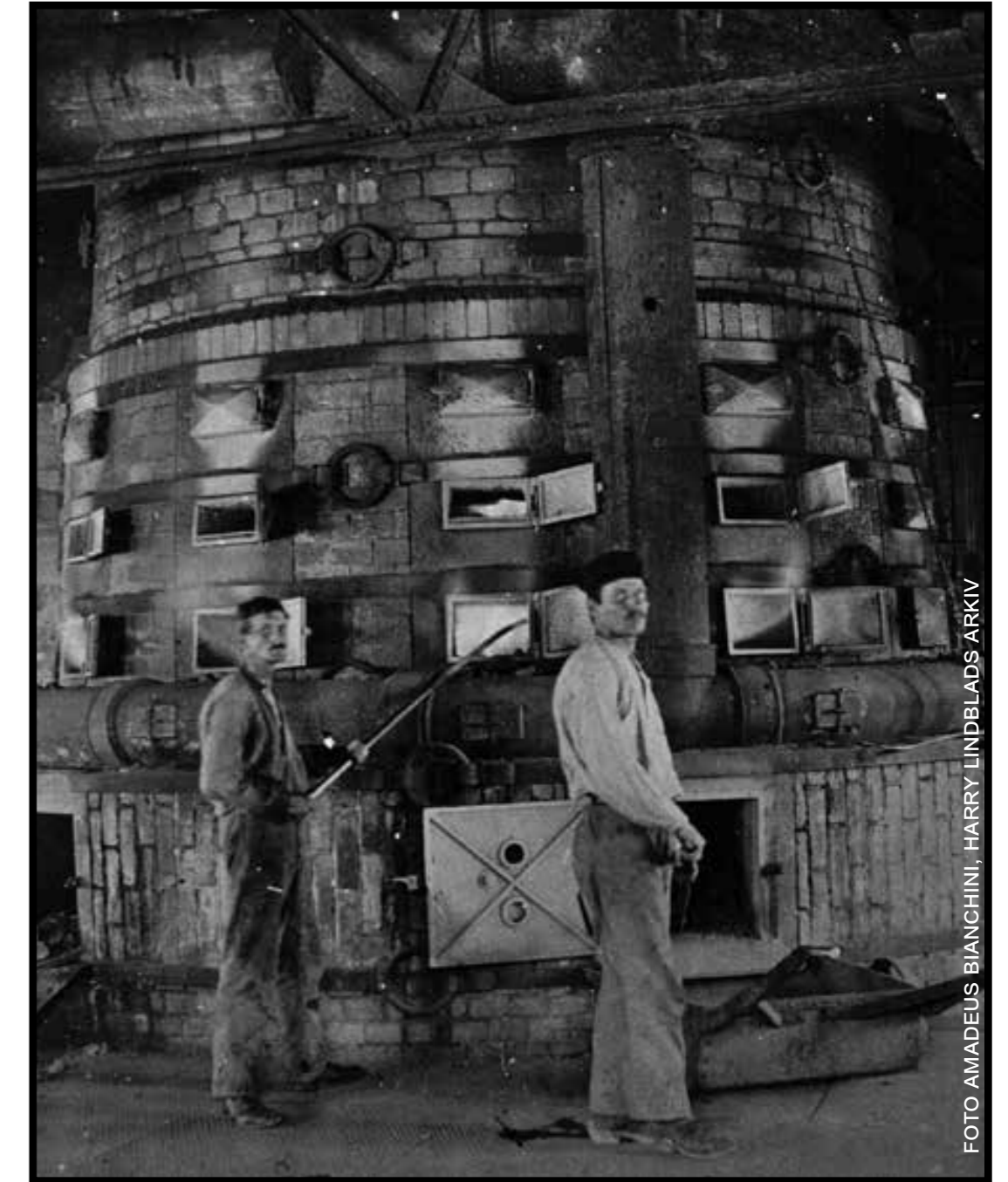
Rostugnen, 1919. Här rostades malmen för att bli porös och gå lätt att dela i mindre bitar.
