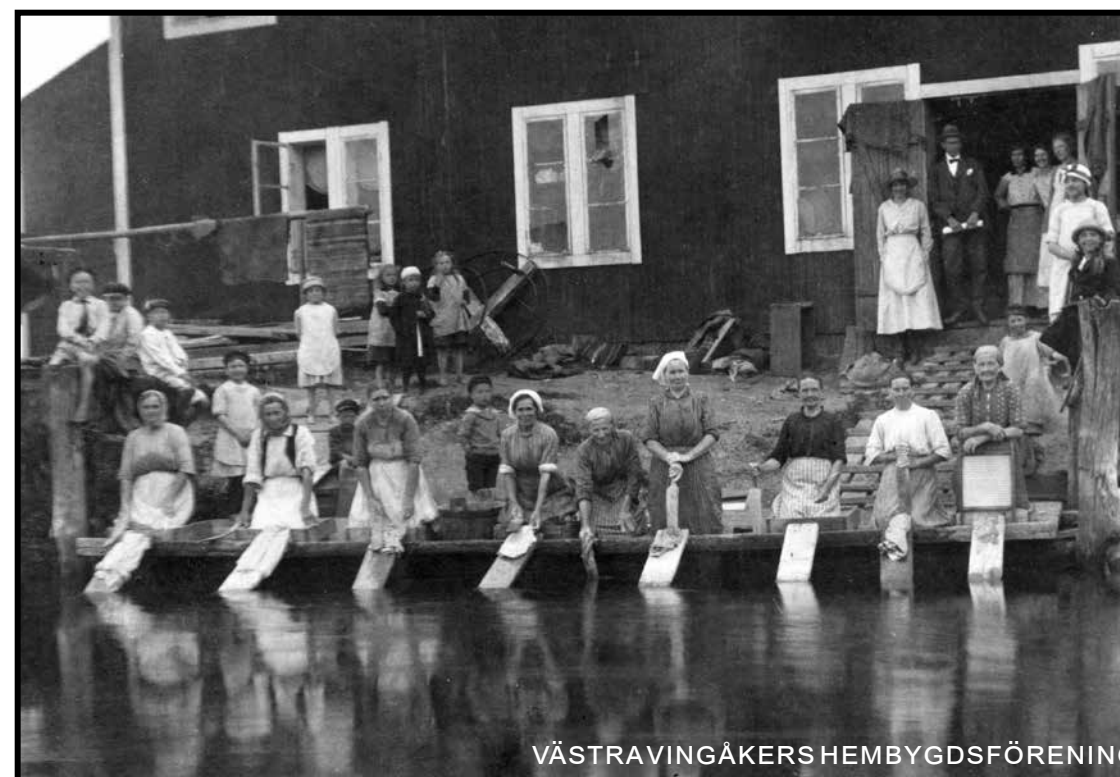
Tvättstugor utanför Vingåkers första badstuga, som var kombinerad tvättstuga och bad. Troligen 1910-tal. Det nuvarande badhuset öppnade 1985.
