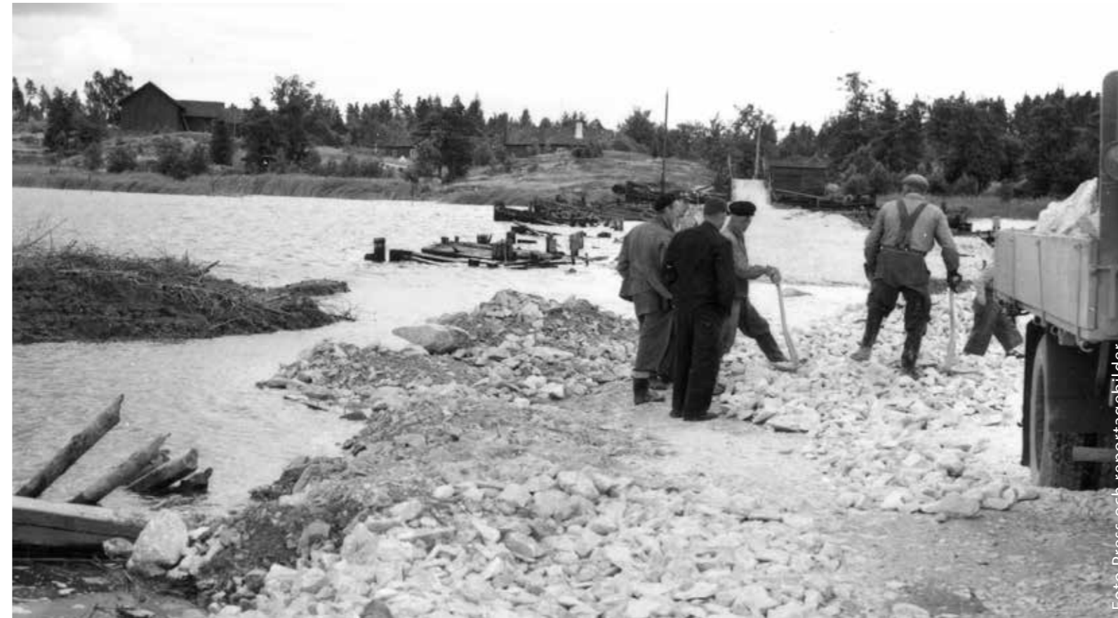
Vägbanken är byggd på prämar, rester av dem sticker upp här på bilden som togs 1952.
