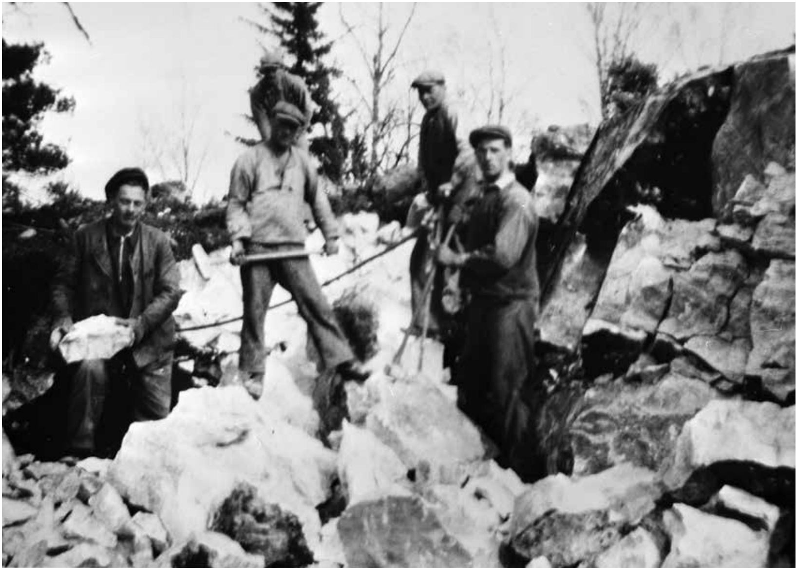
De stora kalkstensblocken som bildades vid sprängningen knackades till mindre stenar som därefter tömdes i ugnen. Gunnar Andersson står till höger.
