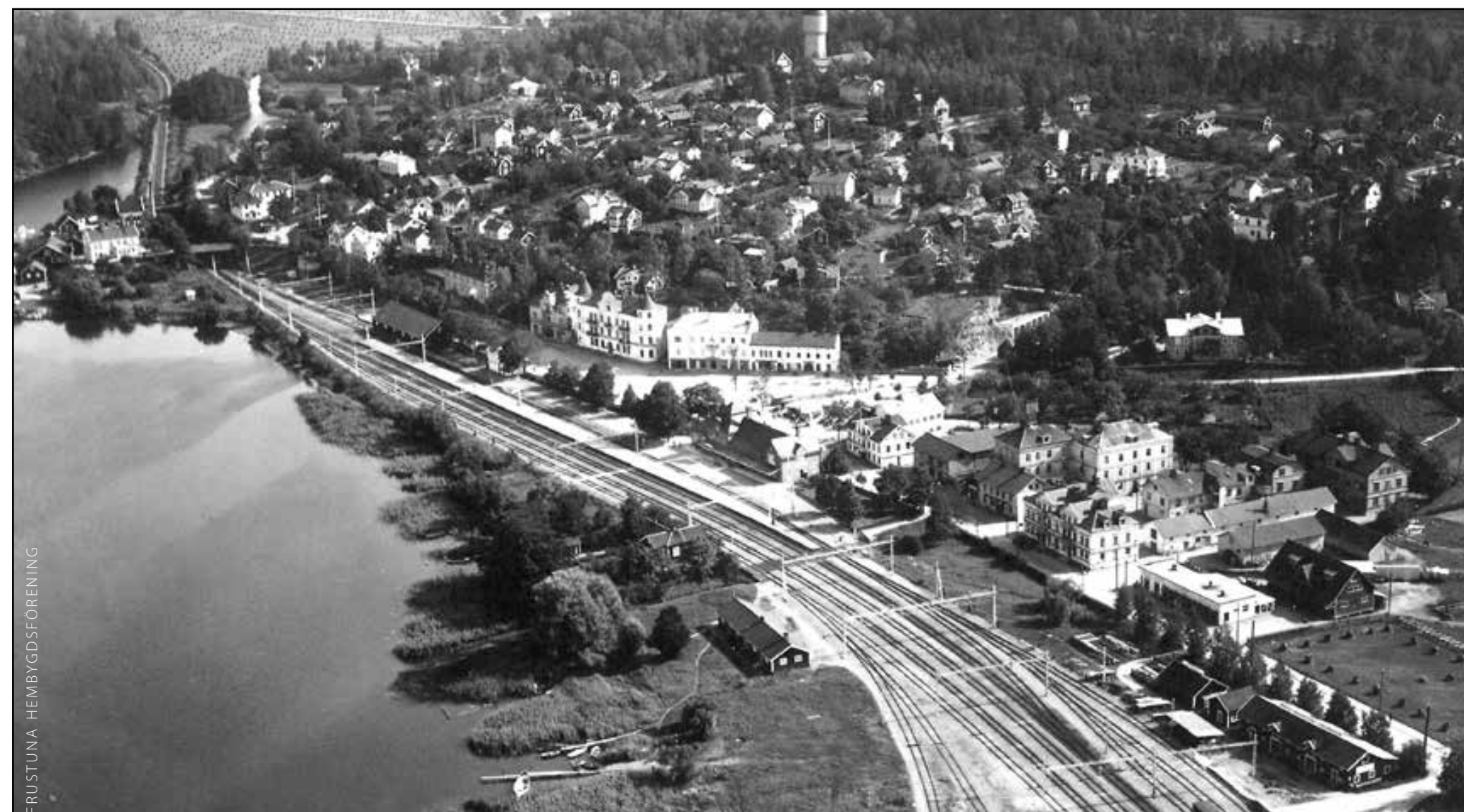
Gnesta stationsområde var ett komplicerat byggnadsprojekt för rallarna. Man var tvungen att göra en så kallad sjösänkning – delar av Frösjön fylldes igen så att det blev land istället. På den nya landremsan byggdes sedan järnvägen. Bilden är tagen 1935.
