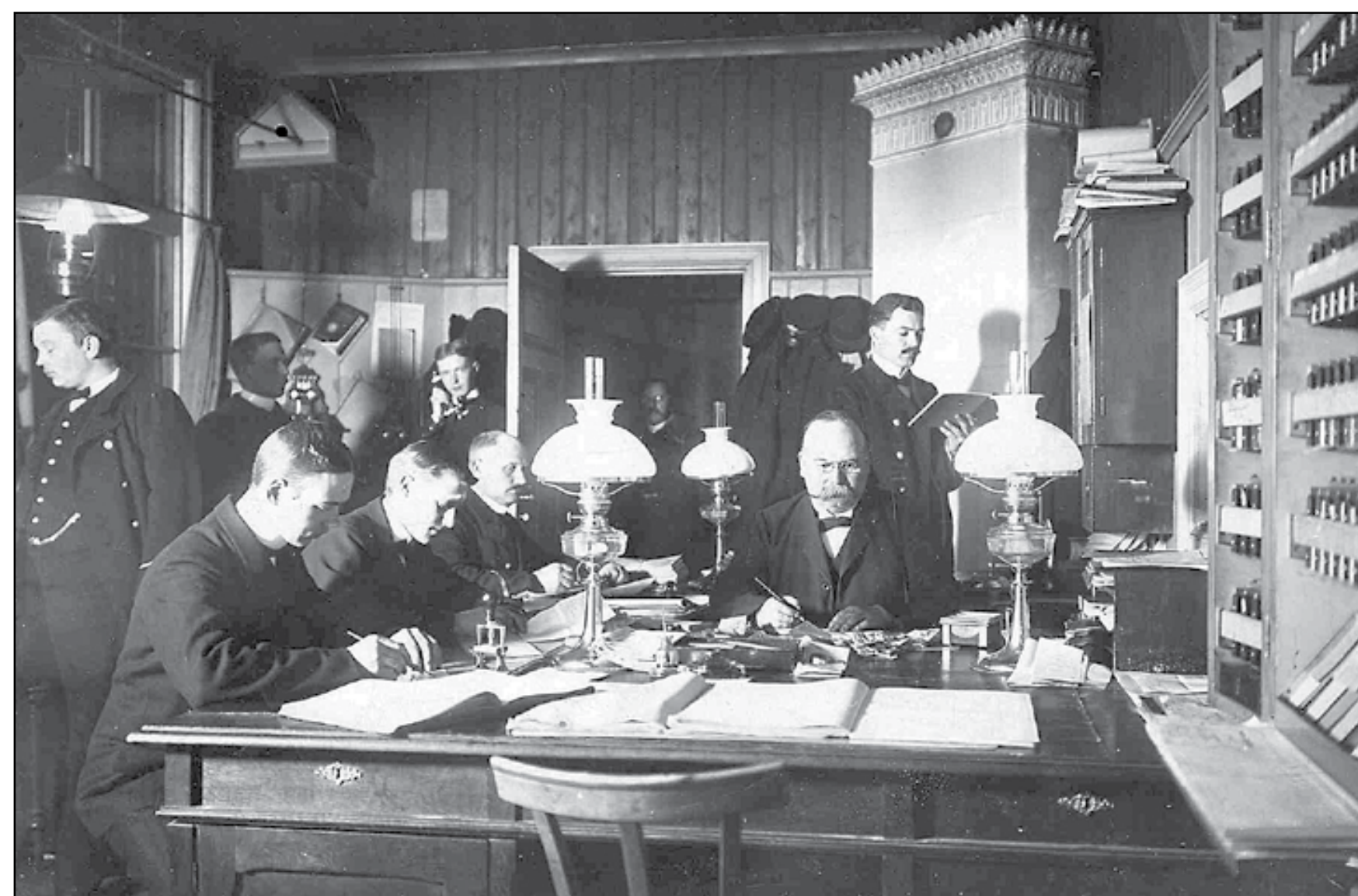
Gnesta järnvägsstation 1890. Personal poserar med sina statusfyllda sysslor.
