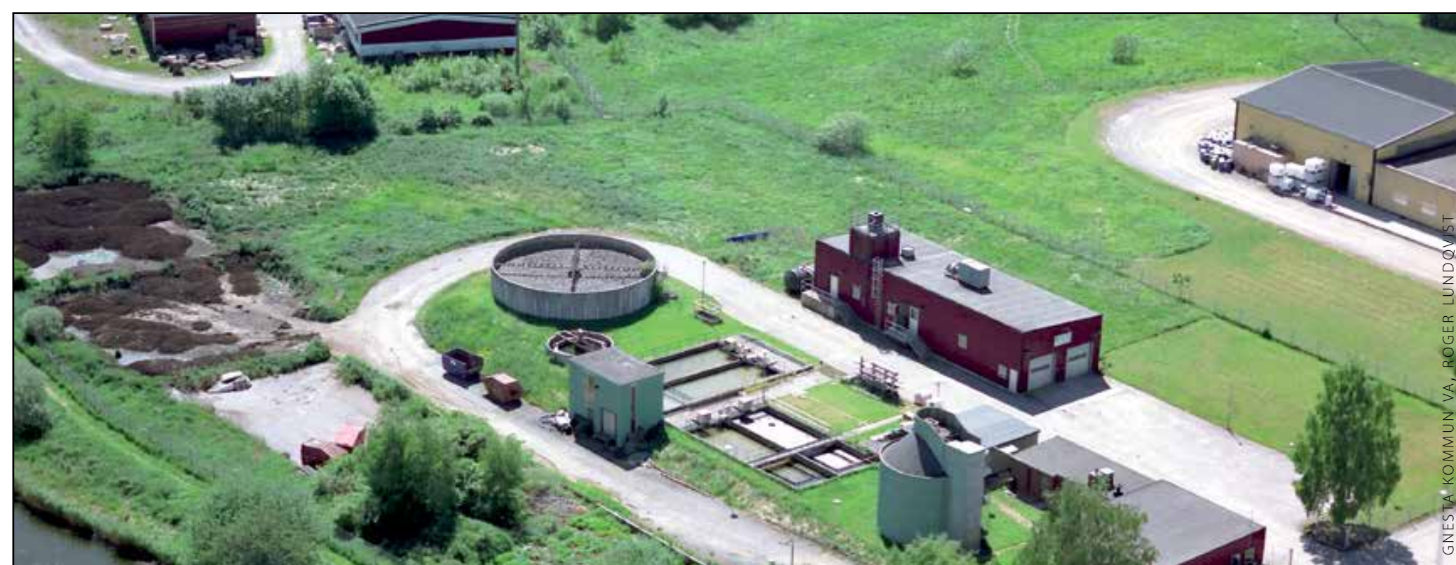
Reningsverket i Gnesta på Ågatan 8.
