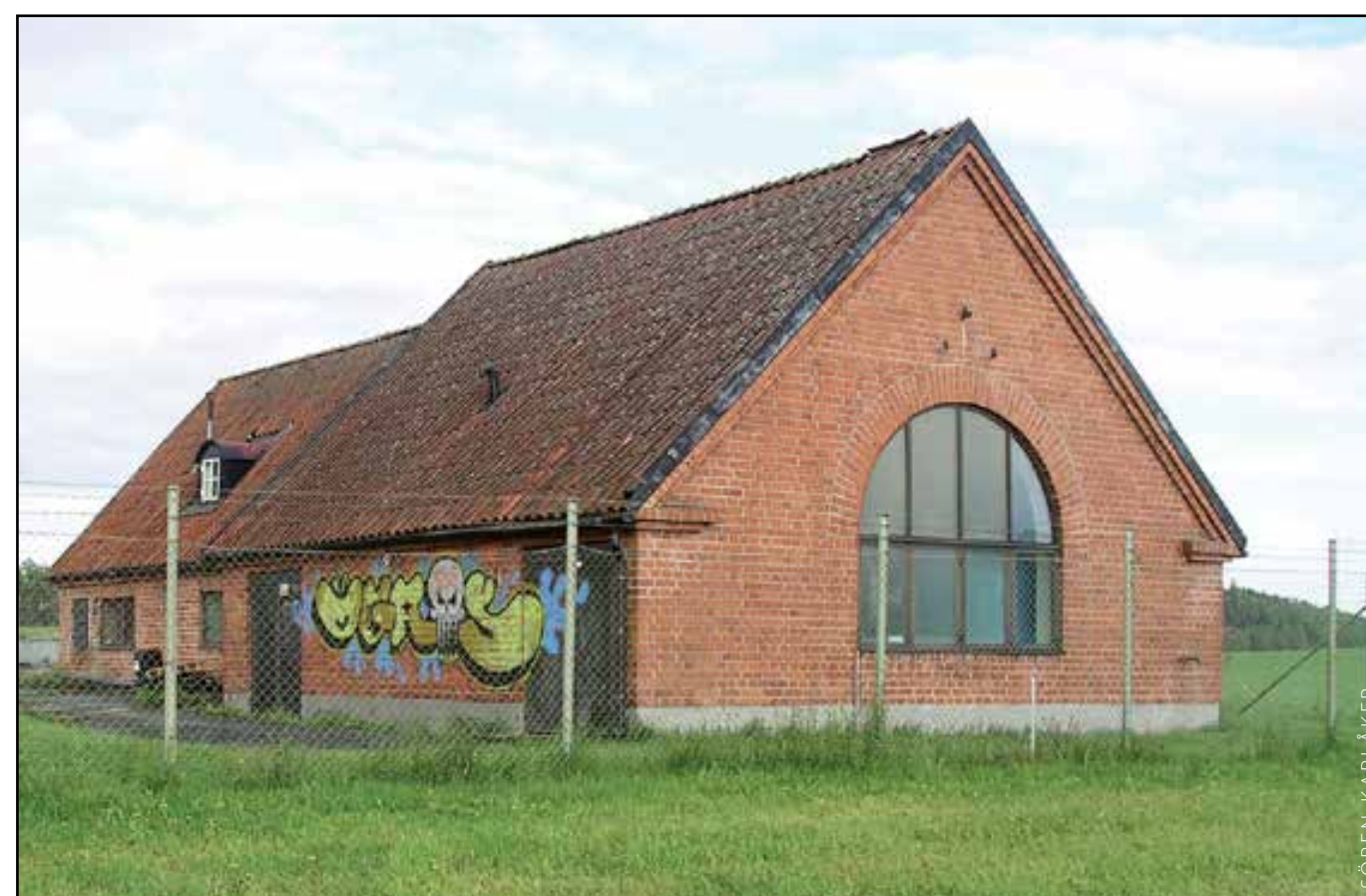
Pumpstationen på Visbohammars gärde.
