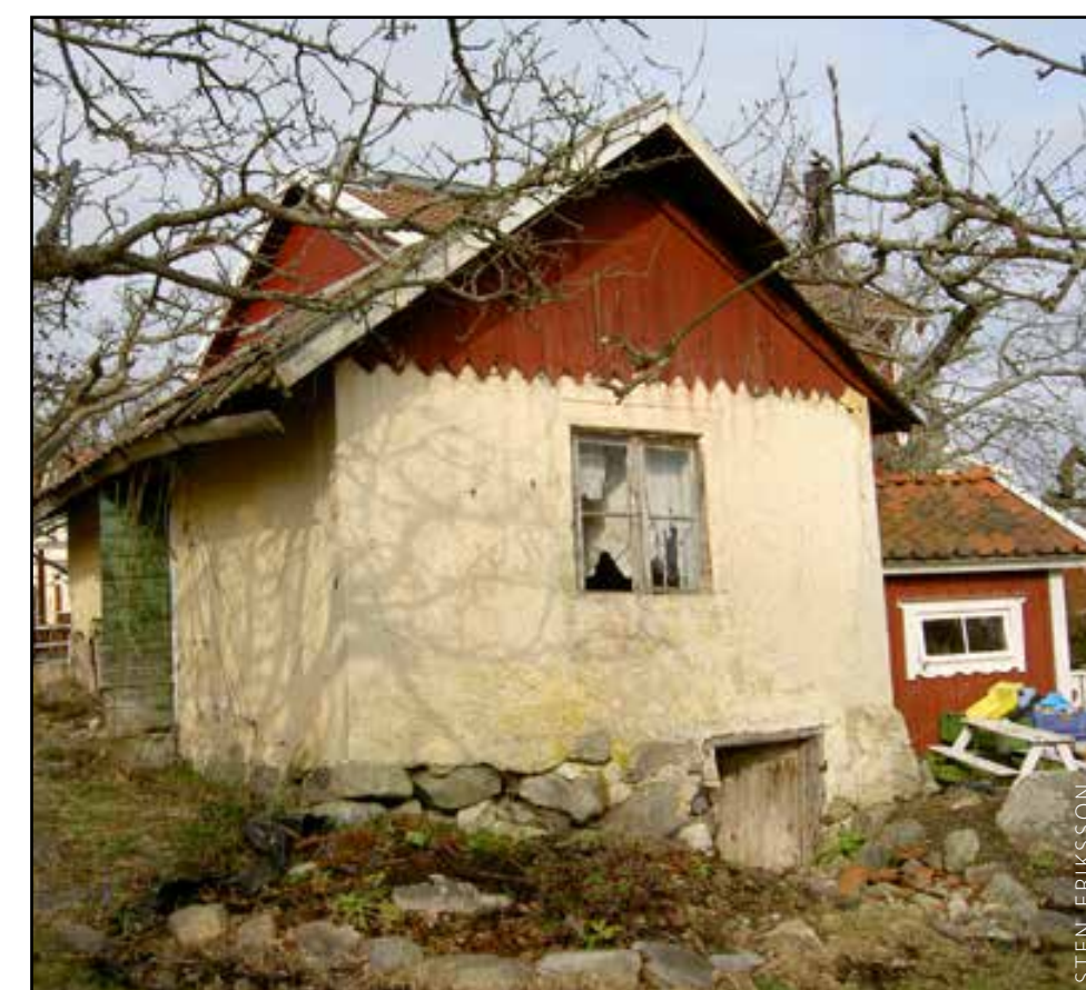
Gnestas äldsta hus ligger på hörnet Skolgatan/Mosebacke. Huset fanns redan på Gnestahöjden när den började bebyggas 1862.
