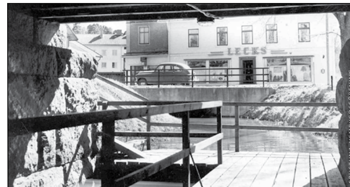
Marieströmsån flöt öppet genom samhället fram till 1968 då den överdäckades.
