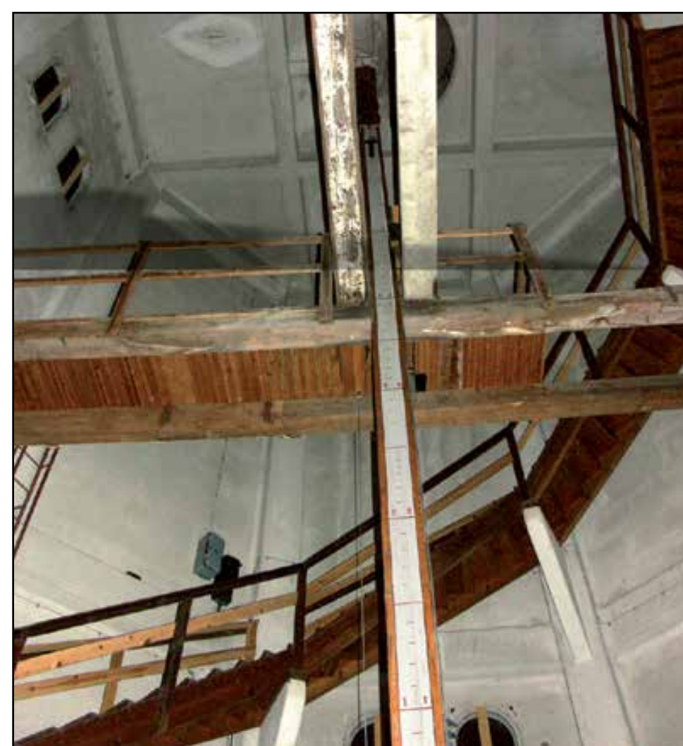
Interiör från det gamla vattentornet.
