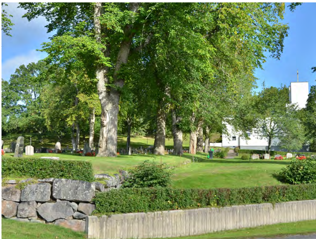
11 Murarna i söder. Stenmuren till vänster omger den gamla delen och betongmuren till höger den nya kyrkogårdsdelen i öster (SLM D2019-0076).
