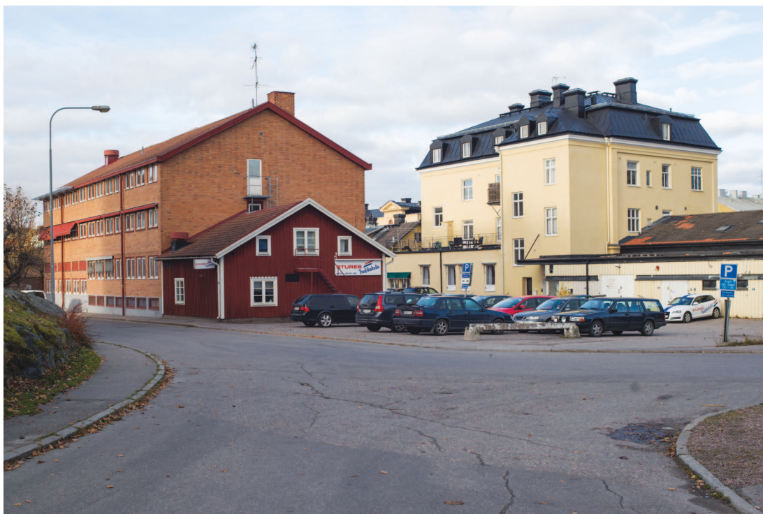
A5. Fotografi över motsvarande siktlinje. Utsikten domineras av det före detta magasinet till vänster samt affärs- och bostadshuset. Här finns tegel, puts och trä representerat i de befintliga fasadmaterialet. (SLM D2015-1576)
