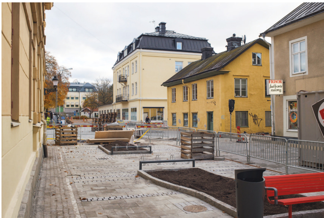
A3. Idag finns en utsikt från Östra Storgatan som i stort sett är oförändrad sedan början på förra seklet. Affärs- och bostadshuset är väl anpassat till Östra folkskolan i färgsättning och fasadmateriell. Puts är det genomgående fasadmaterialet idag. En tillbyggnad i avvikande material och färg kommer störa den visuella helheten, dock först då man närmar sig slutet av Östra Storgatan. (SLM D2015-1575)
