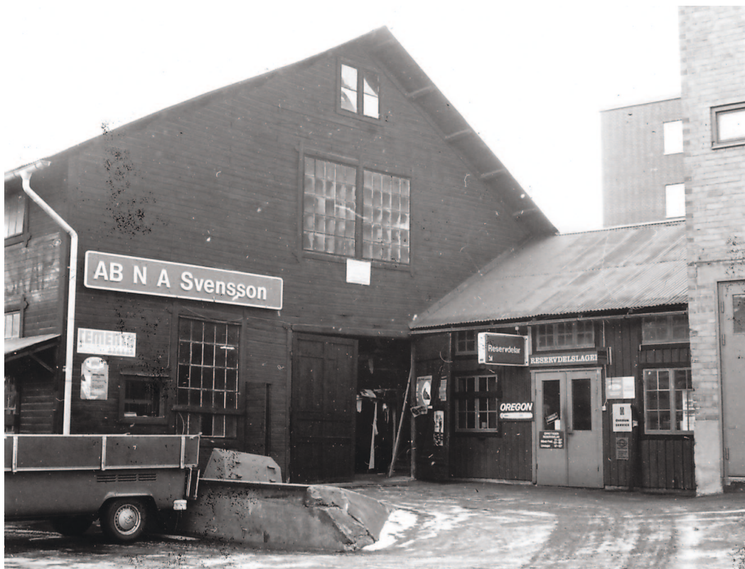
Den äldre lagerbyggnaden till vänster samt det låga hus som fortfarande finns kvar idag i anslutning magasinbyggnaden som syns till höger i bild.. Bilden är tagen i samband med den kulturhistoriska inventeringen 1978-79. Notera lagerbyggnadens stora fönster med tät spröjs samt fönsterfodrens korslagda hörn. Den gamla texten på byggnadens långsida är fortfarande synlig om än något svagt. (Foto ur Sörmlands museums arkiv)
