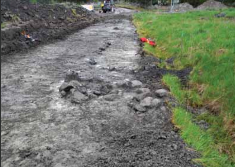
Figur 7. Bild över schaktet. A1 syns i förgrunden och A4 sträcker sig parallellt med befintligt gränsdike. Bilden är tagen från nordnordväst. Foto: Patrik Gustafsson 2012, Sörmlands museum.
