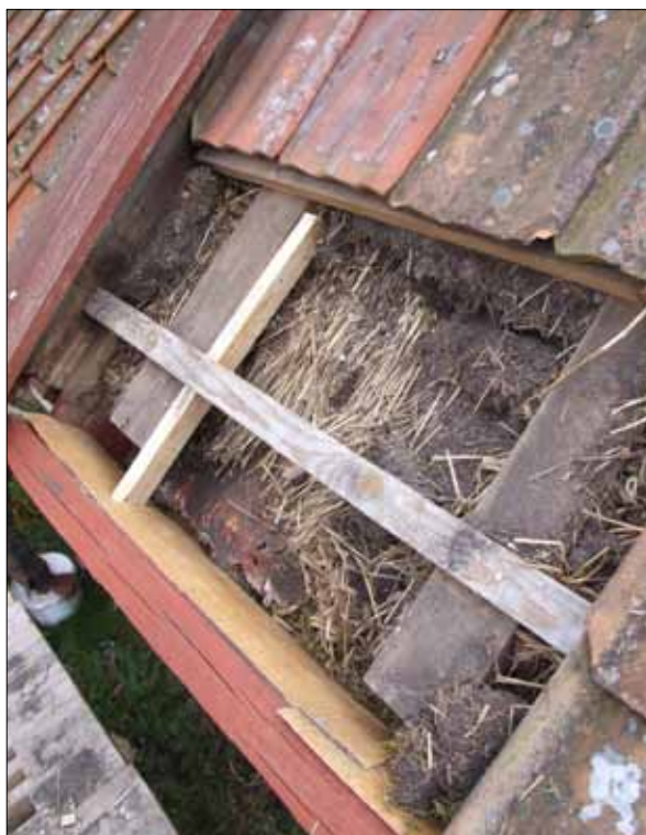
6 En läkt spikades på vissa rafter för att ge stöd åt mullbrädan (Slm D12-0488).
