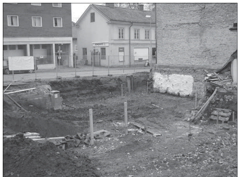
Figur 5. Översikt mot sydväst över det öppnade schaktet och pågående byggnationsarbeten inom Kvarteret Munkbacken 4 i Strängnäs. I bakgrunden syns delar av Storgatan. Foto: Lars Norberg, Sörmlands museum.
