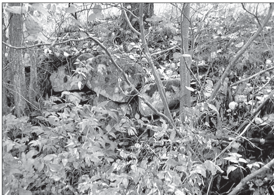
Figur 12. Objekt 6. Del av ett kallmurat fundament tillhörigt en vattendriven såg- eller kvarnanläggning. Foto: Patrik Gustafsson.
